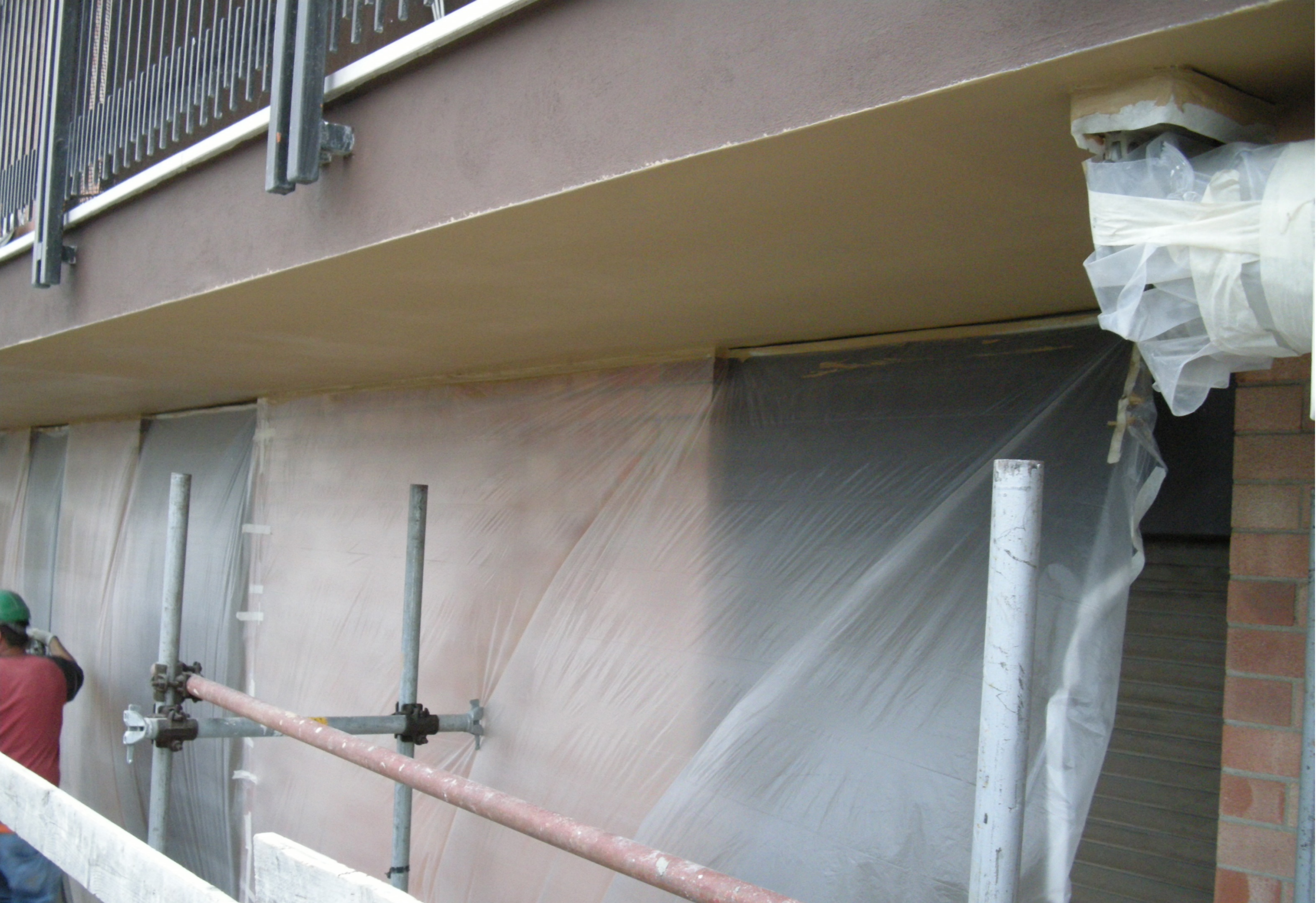
Fase di tinteggiatura ad intervento ultimato
