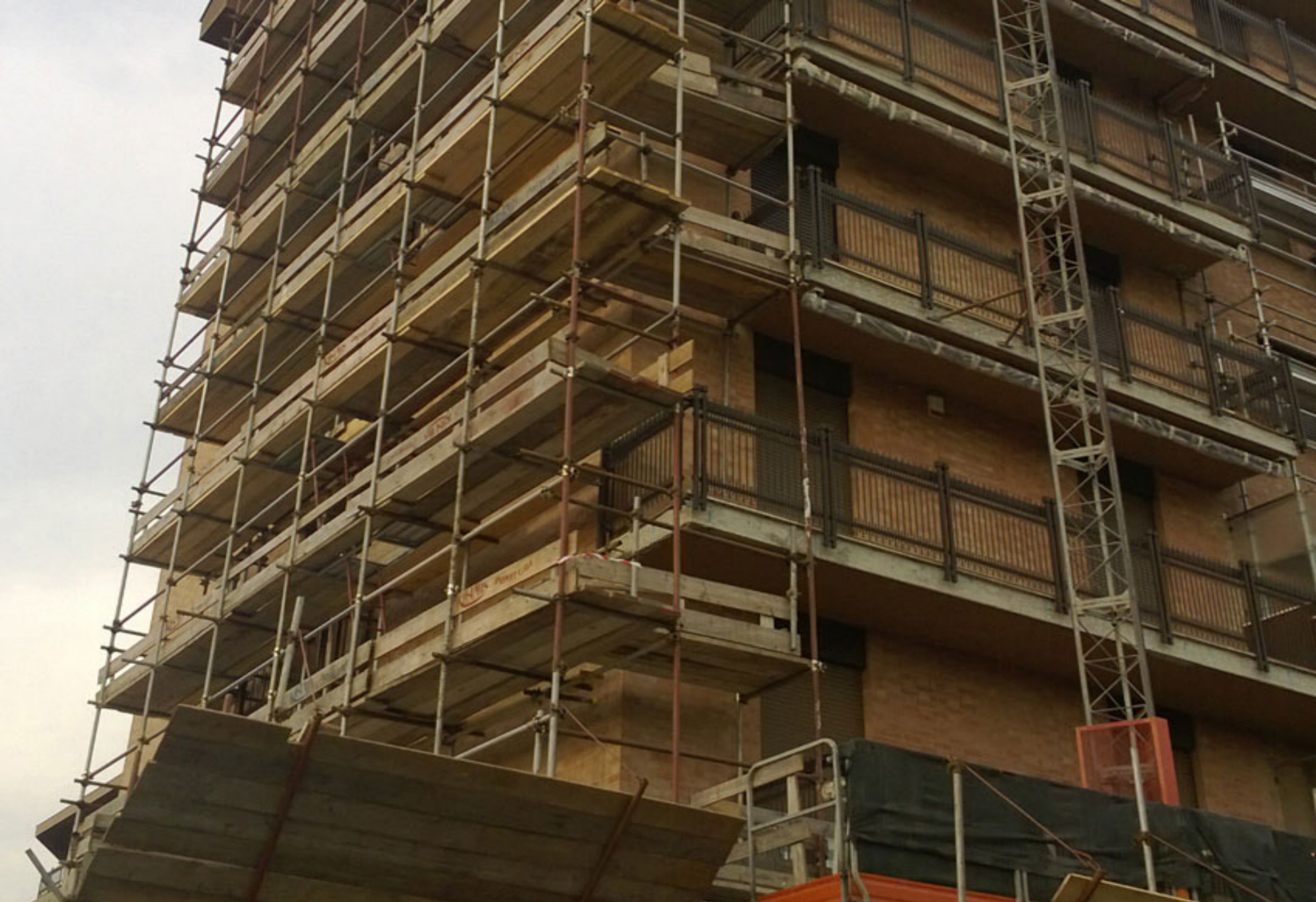
Ponteggi durante le fasi di lavoro
