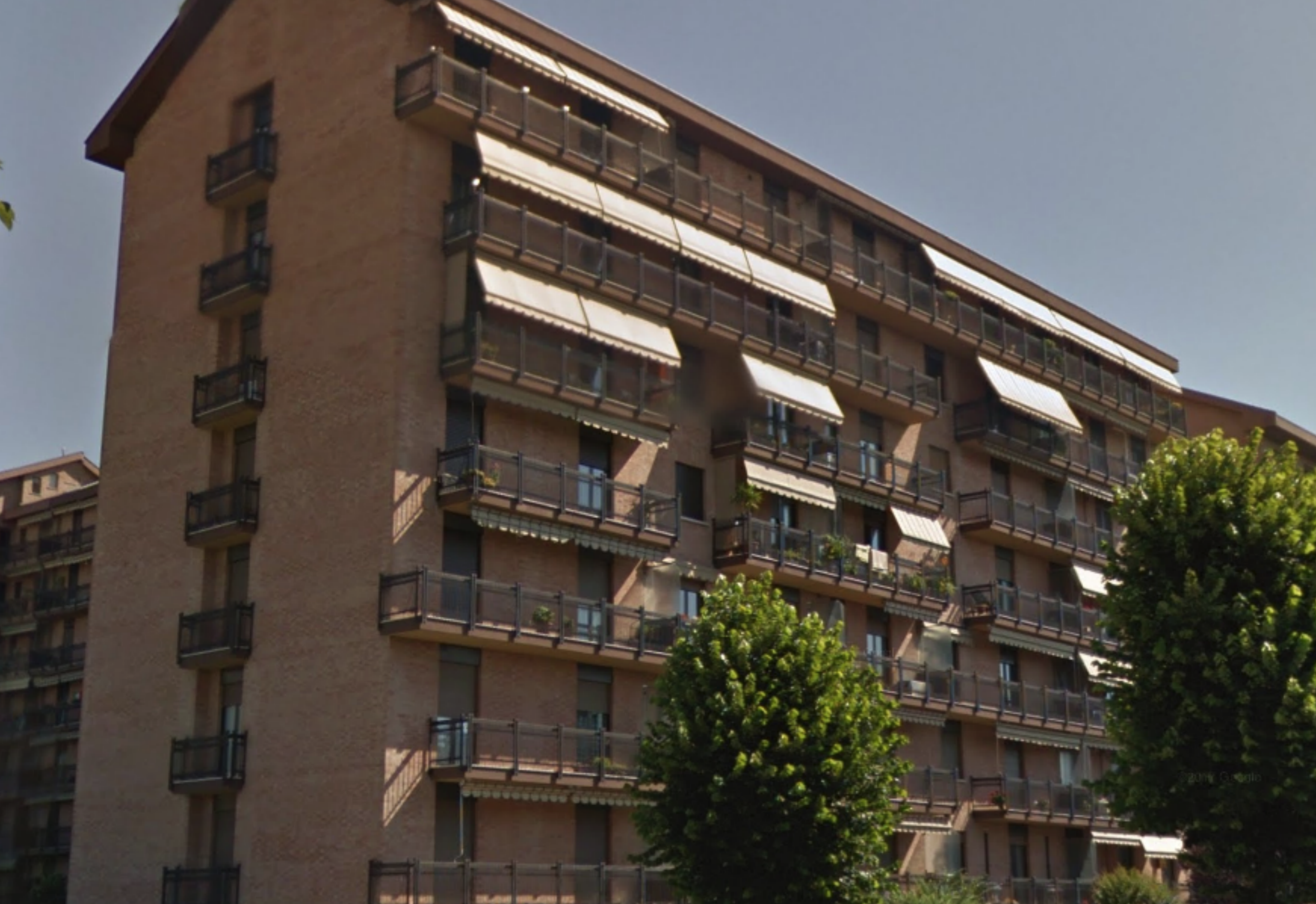
Vista della facciata ad intervento ultimato
