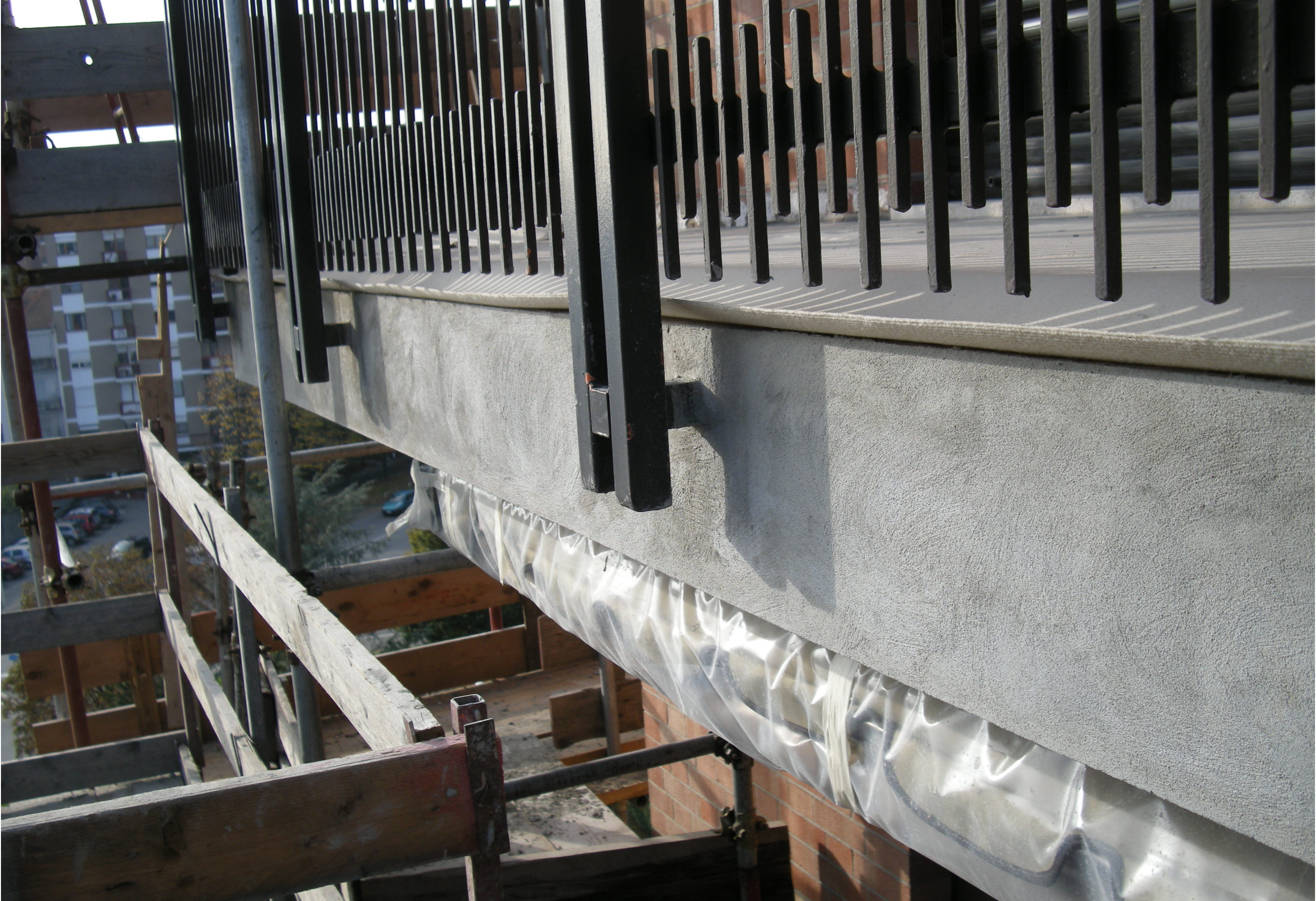
Ripristino dei frontalini ammalorati
