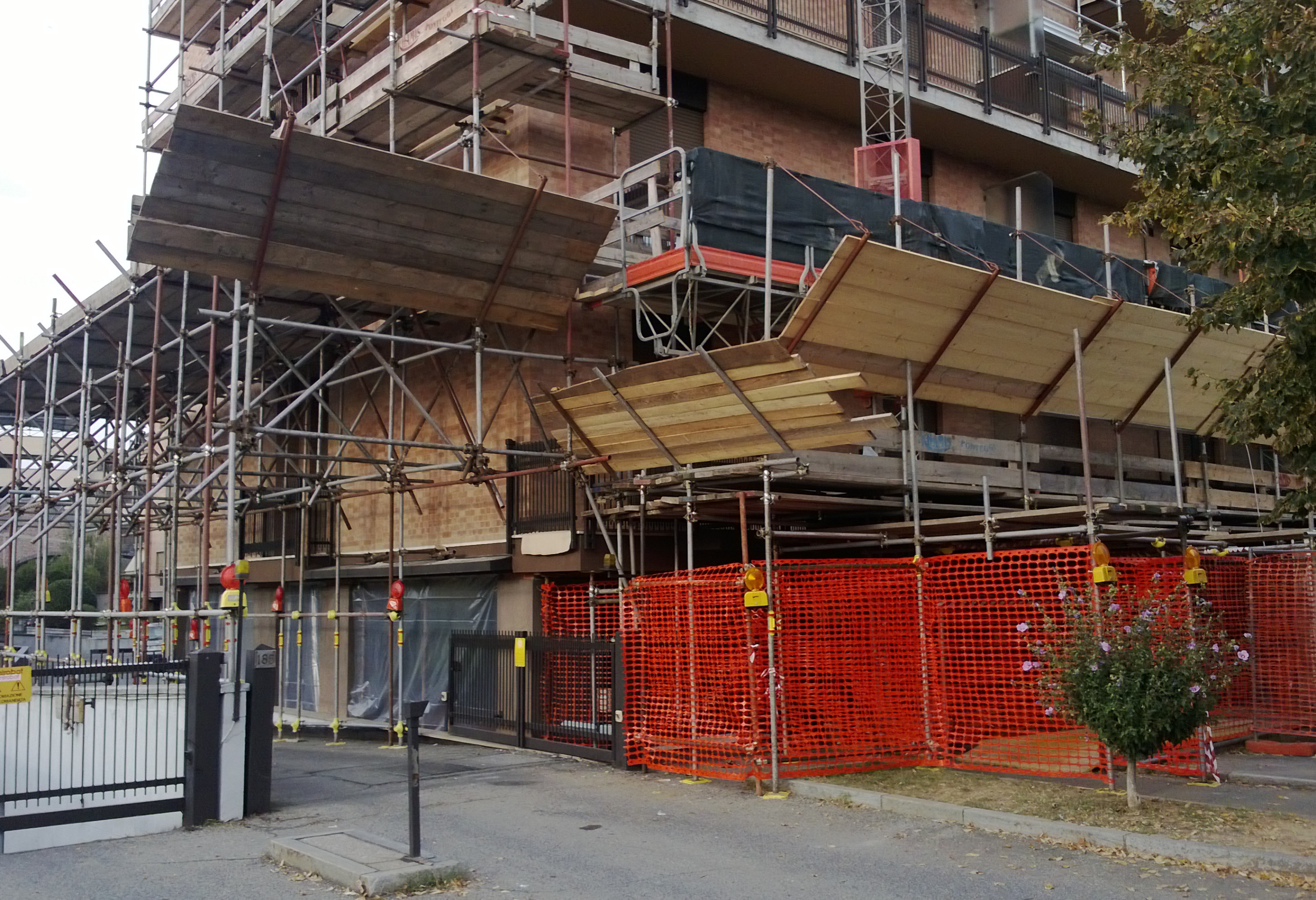
Vista della facciata durante l'esecuzione dei lavori
