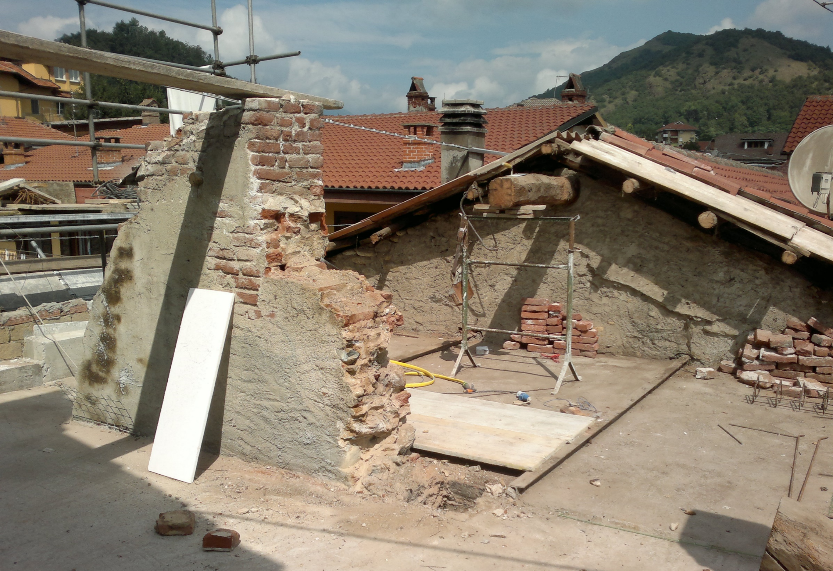
Demolizione del tetto
