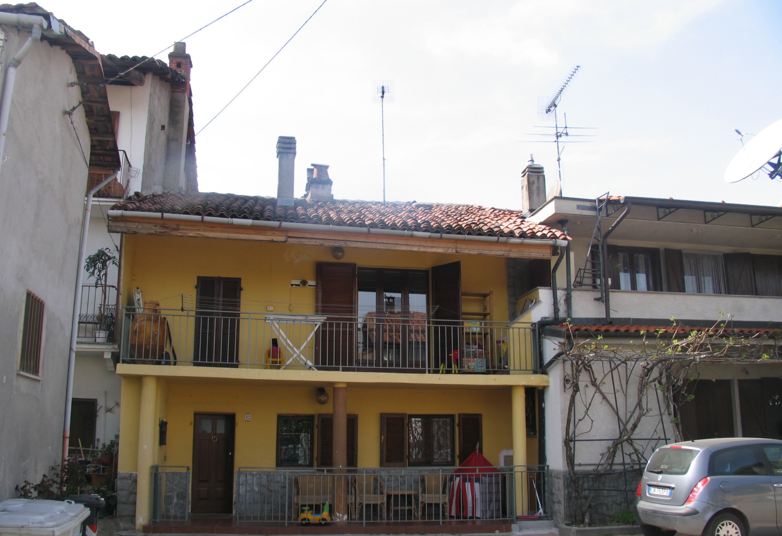
Vista del prospetto dell'edificio antecedente ai lavori
