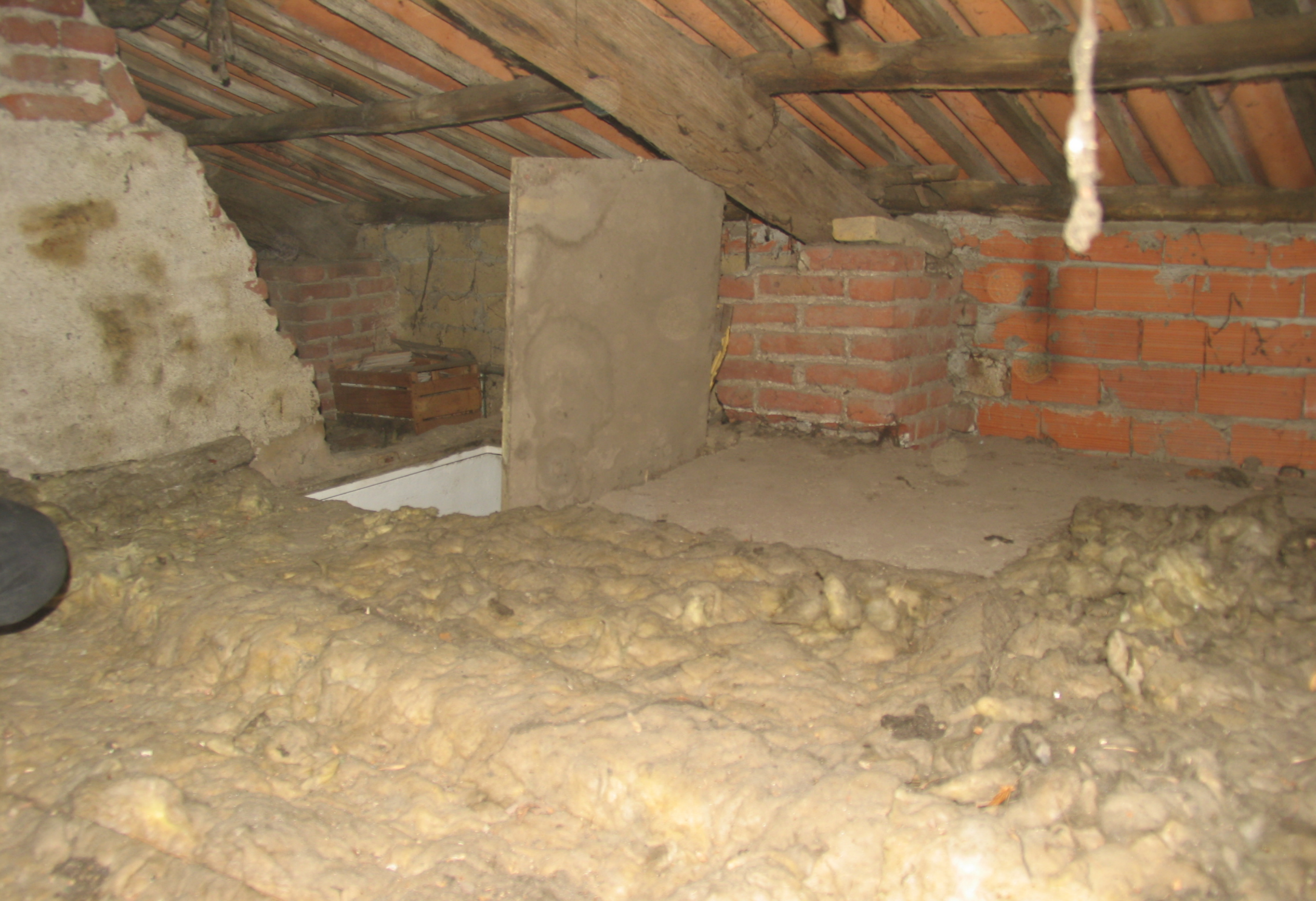
Vista del sottotetto antecedente ai lavori
