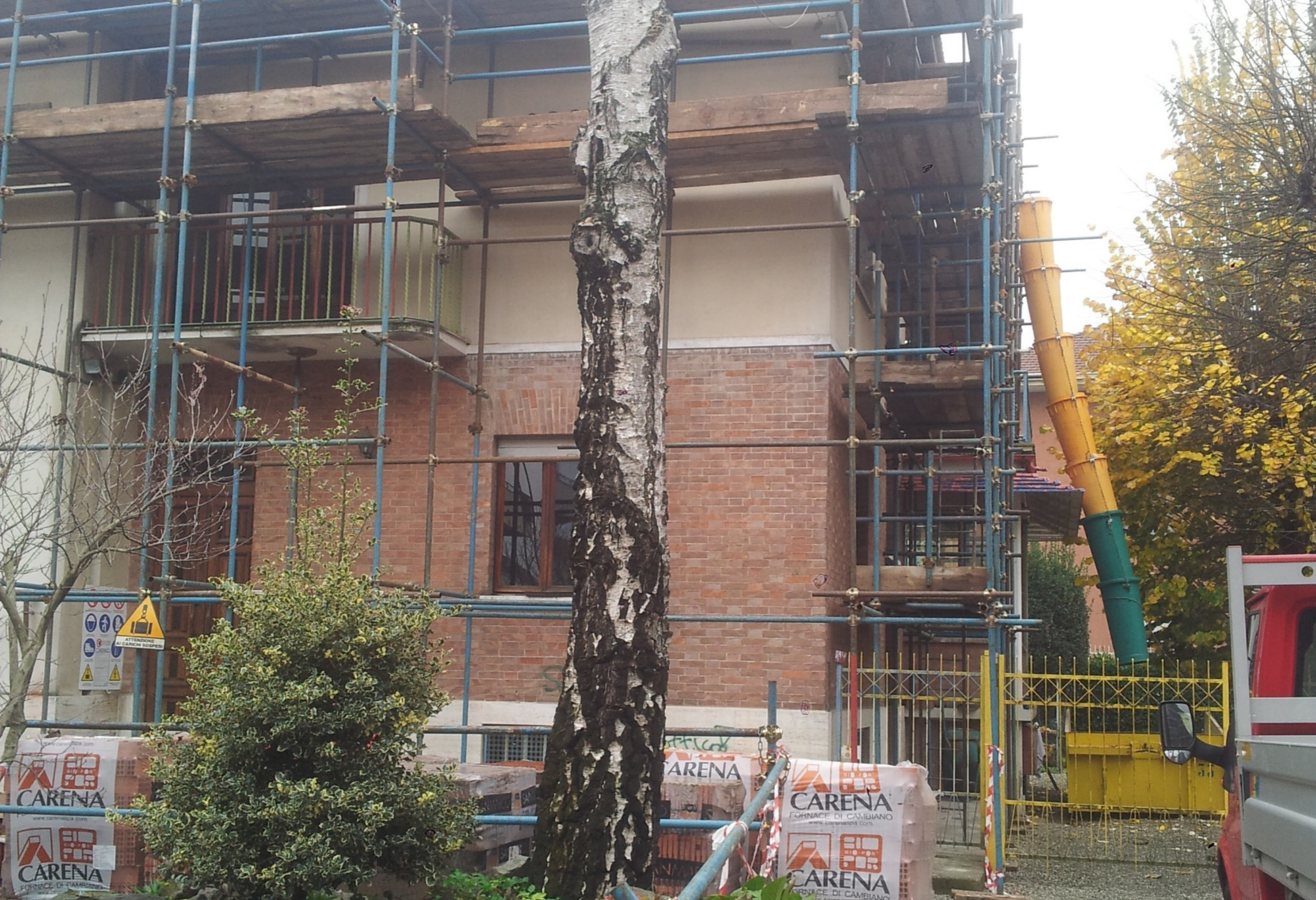
Vista del cantiere durante l'intervento
