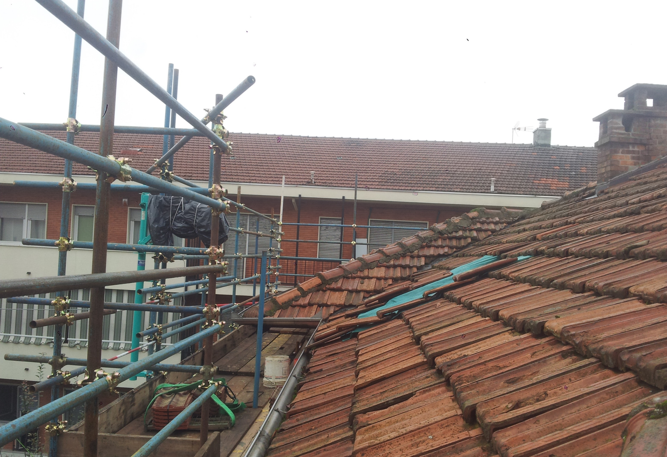
Ponteggi durante le fasi di lavoro
