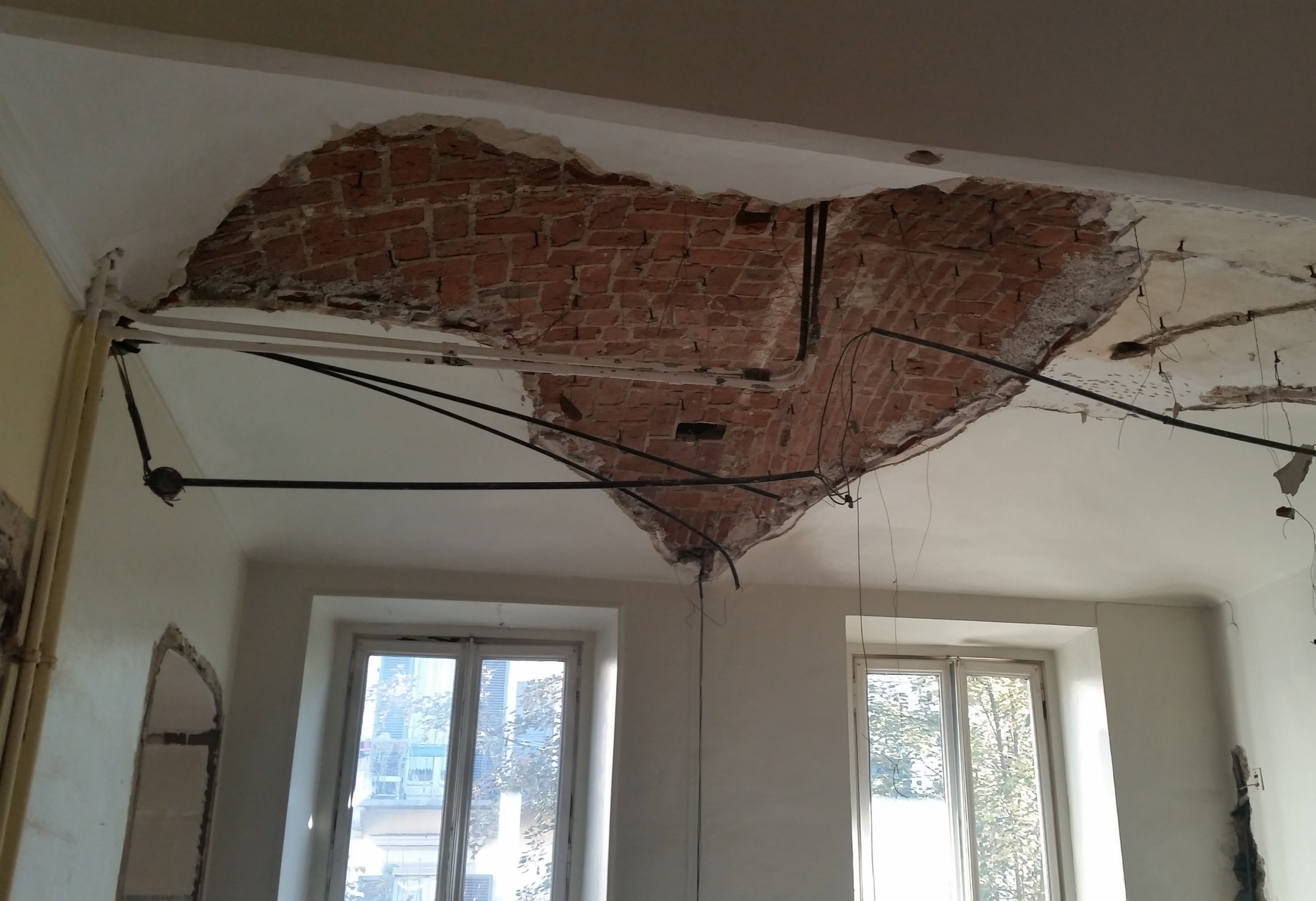
Rimozione dell'intonaco sulla volta in mattoni
