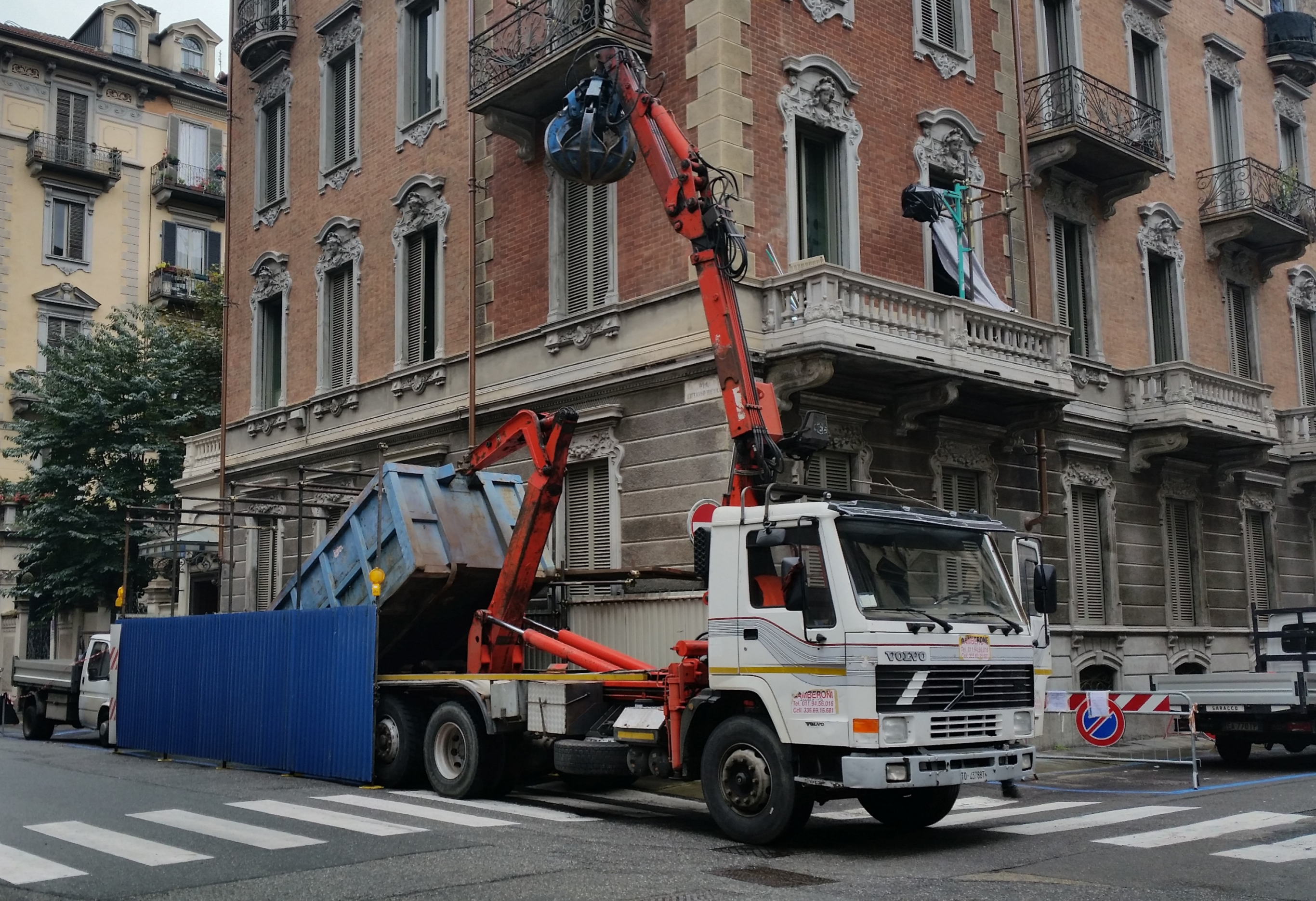
Area di cantiere su strada per smaltimento rifiuti
