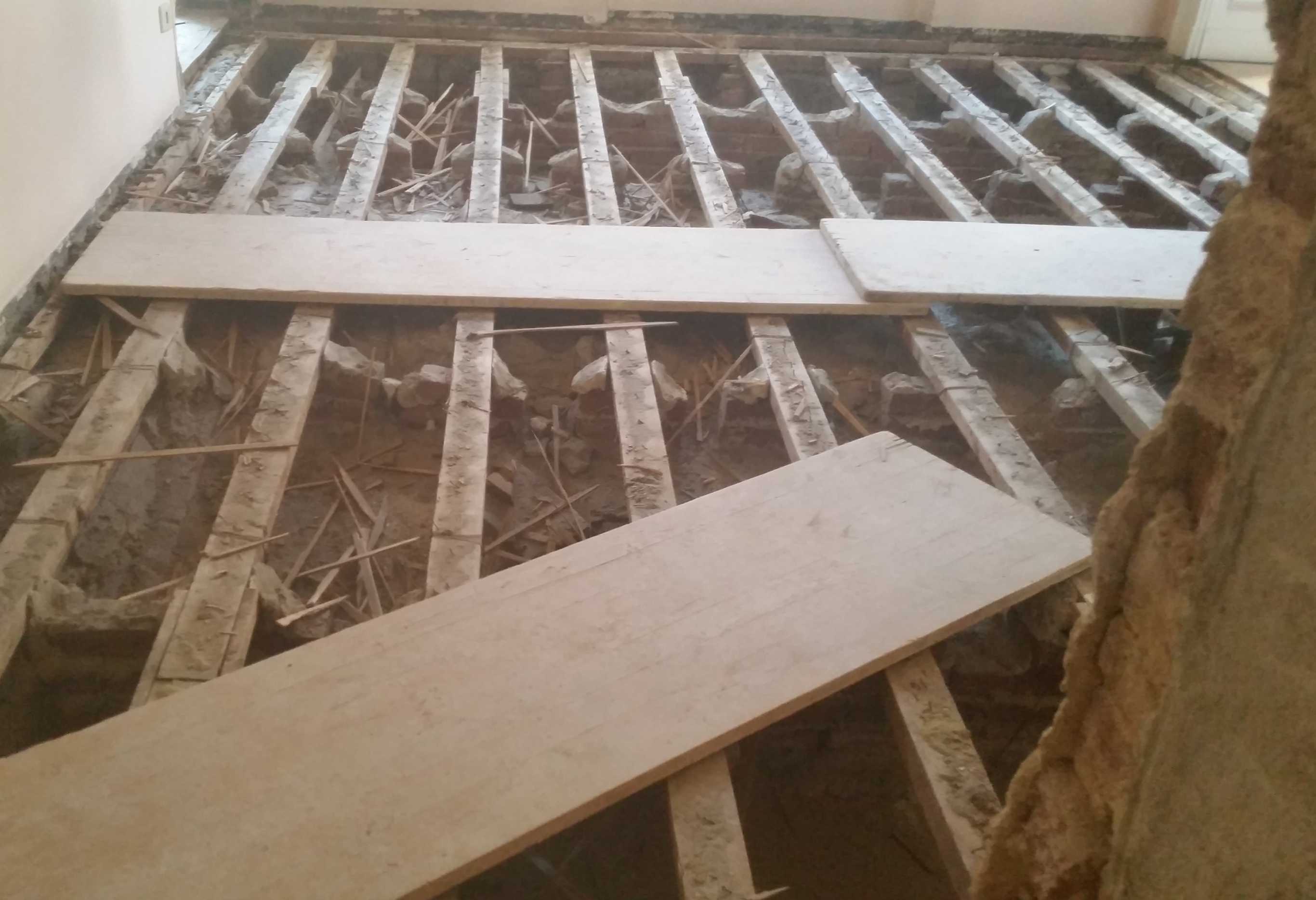
Smantellamento pavimentazione esistente
