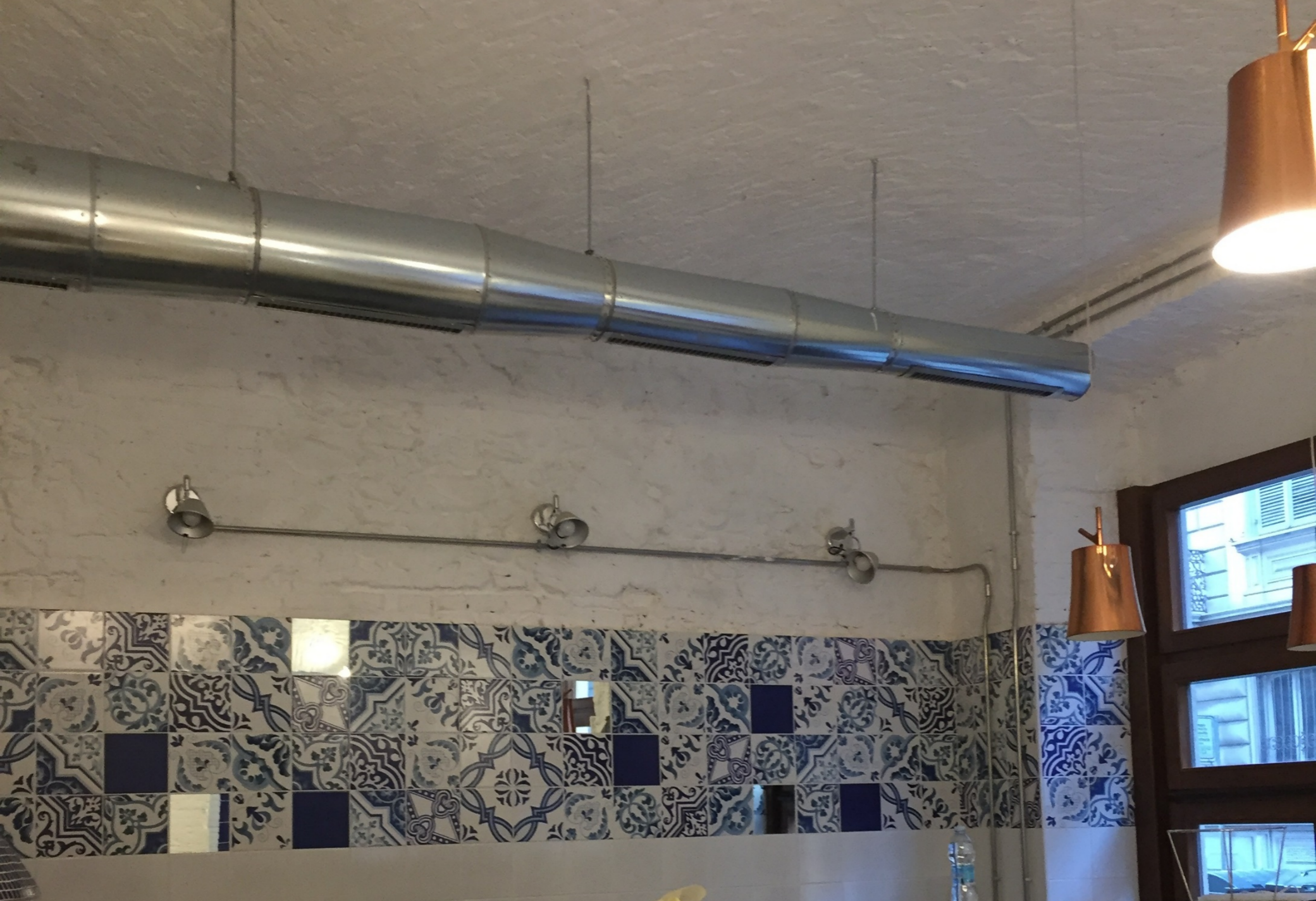
Vista del locale a lavori ultimati. Canalizzazioni aria primaria
