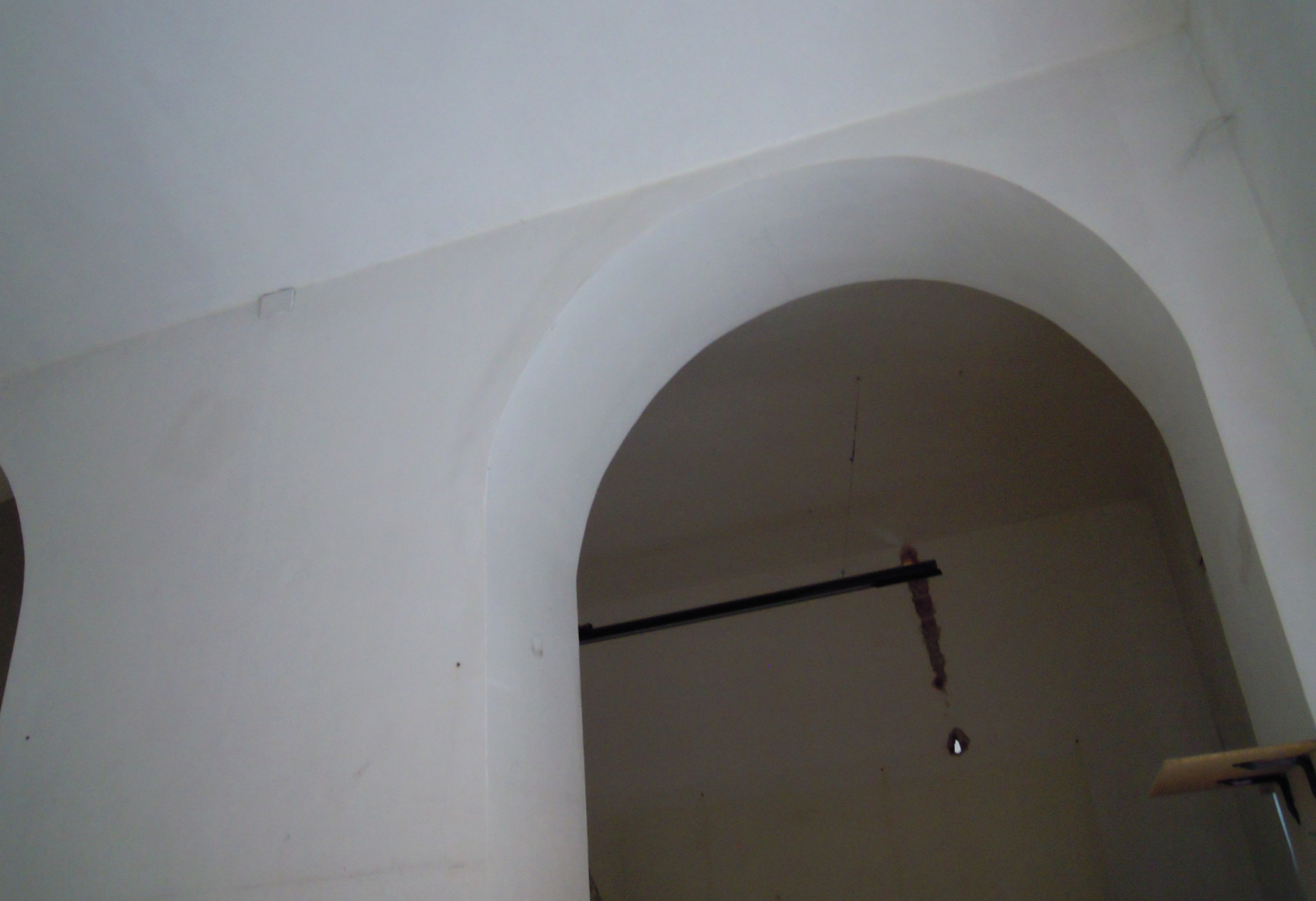
Vista del locale antecedente ai lavori
