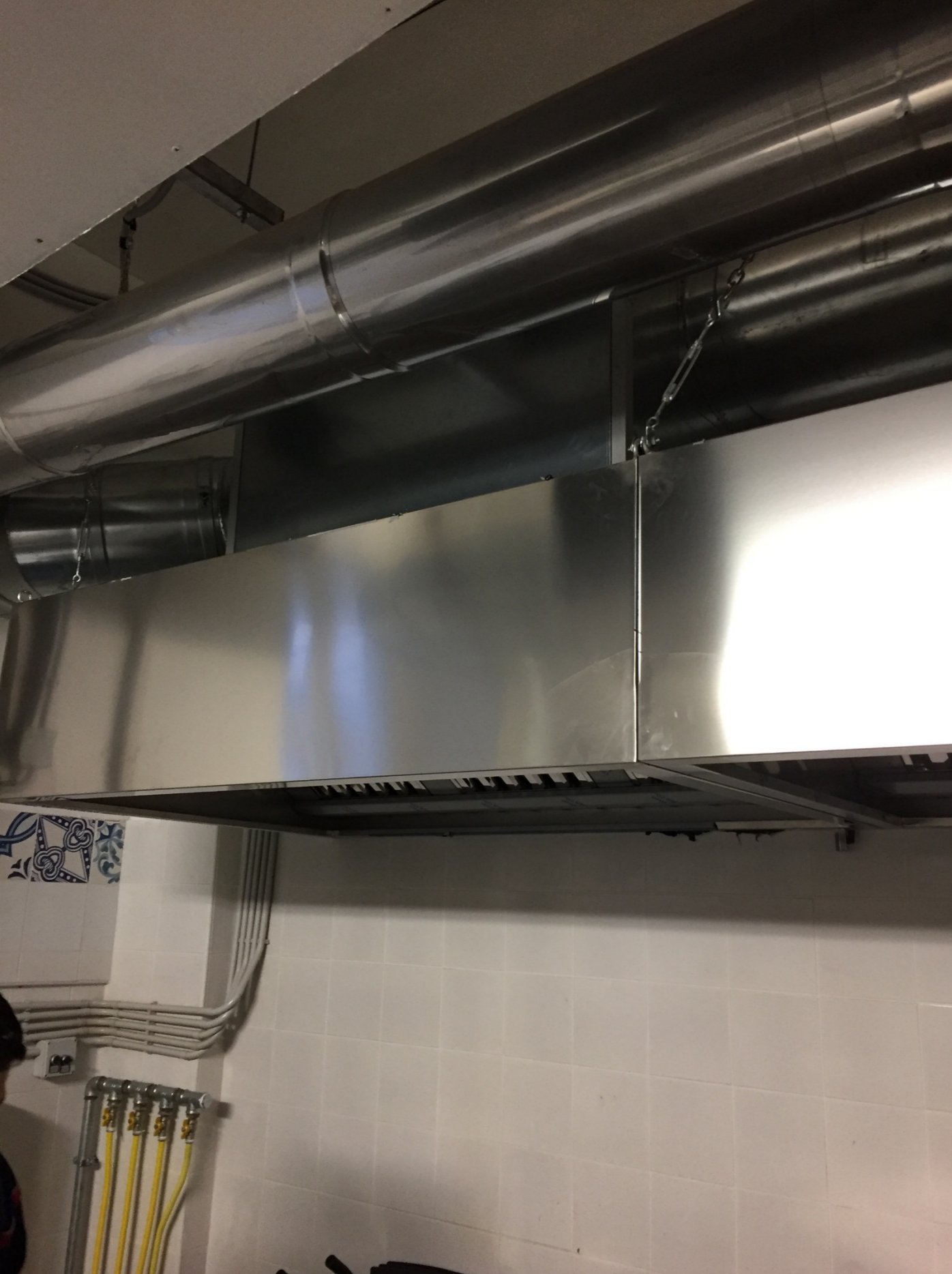
Particolare cappa cucina e canalizzazioni nella sala principale
