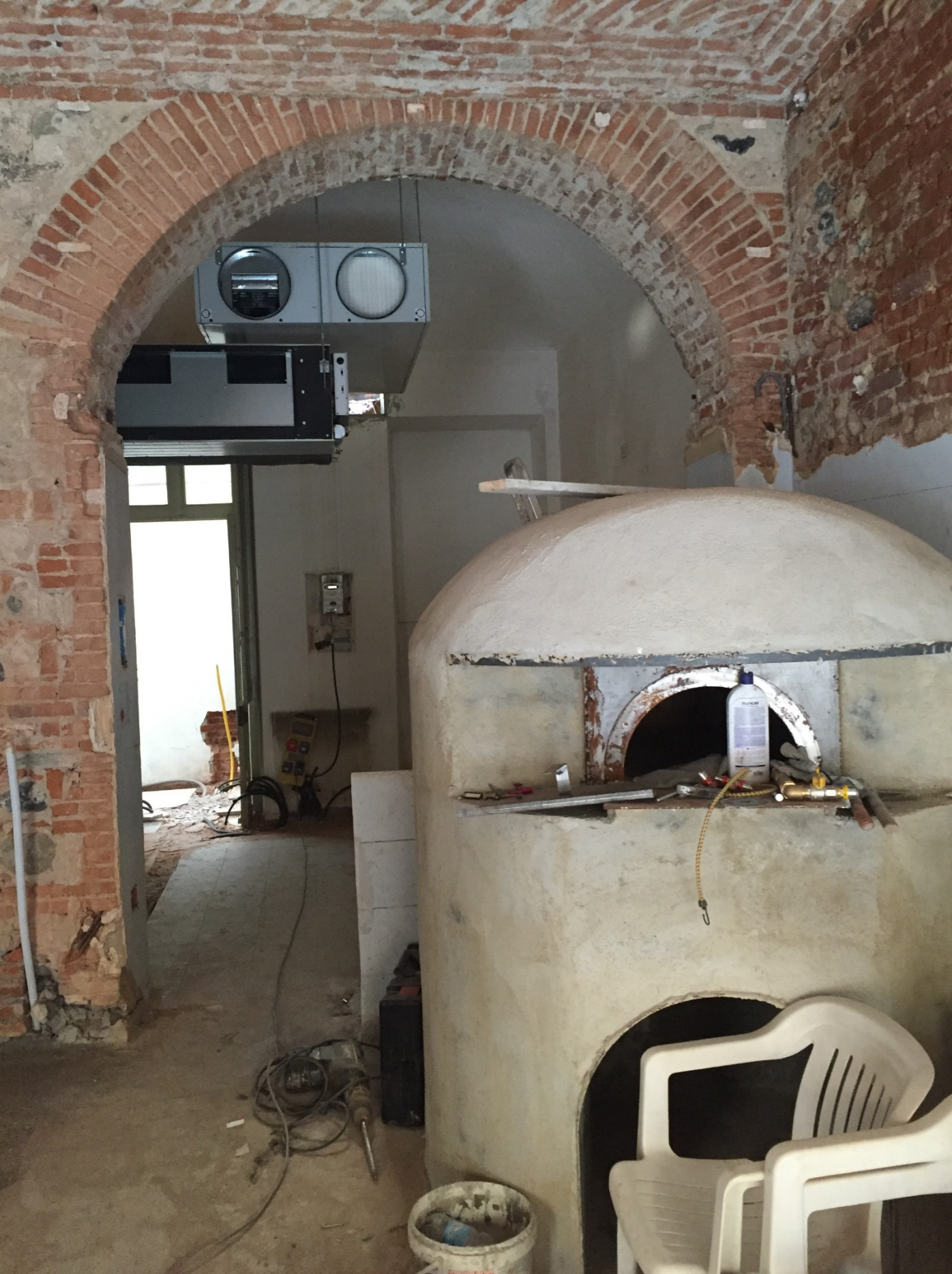
Installazione degli impianti di trattamento aria e climatizzazione estiva ed invernale
