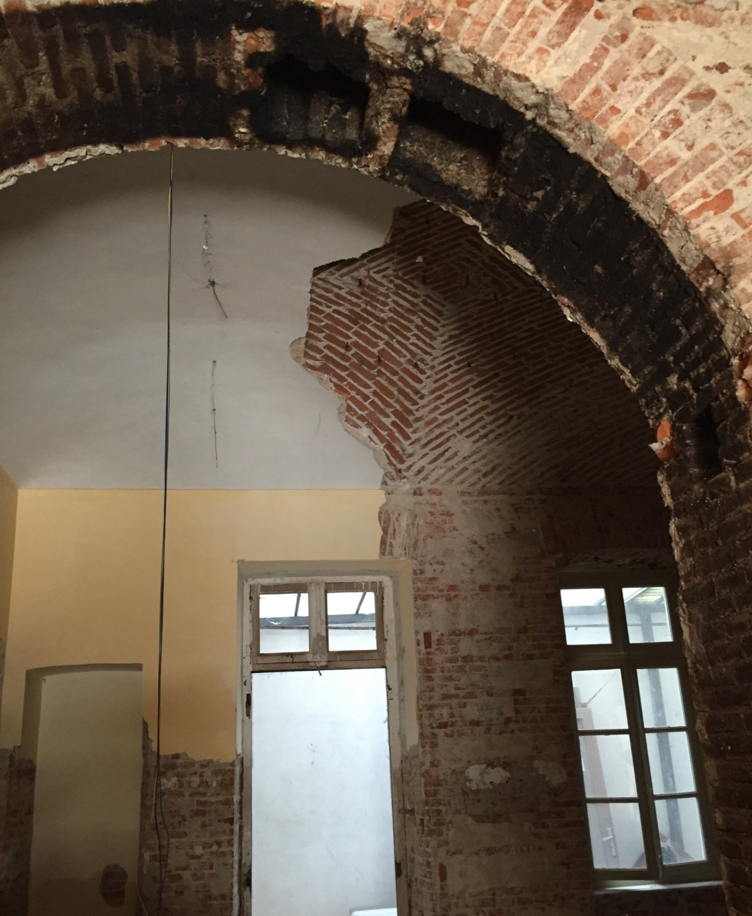
Viste del locale durante i lavori. Rimozione dell'intonaco esistente
