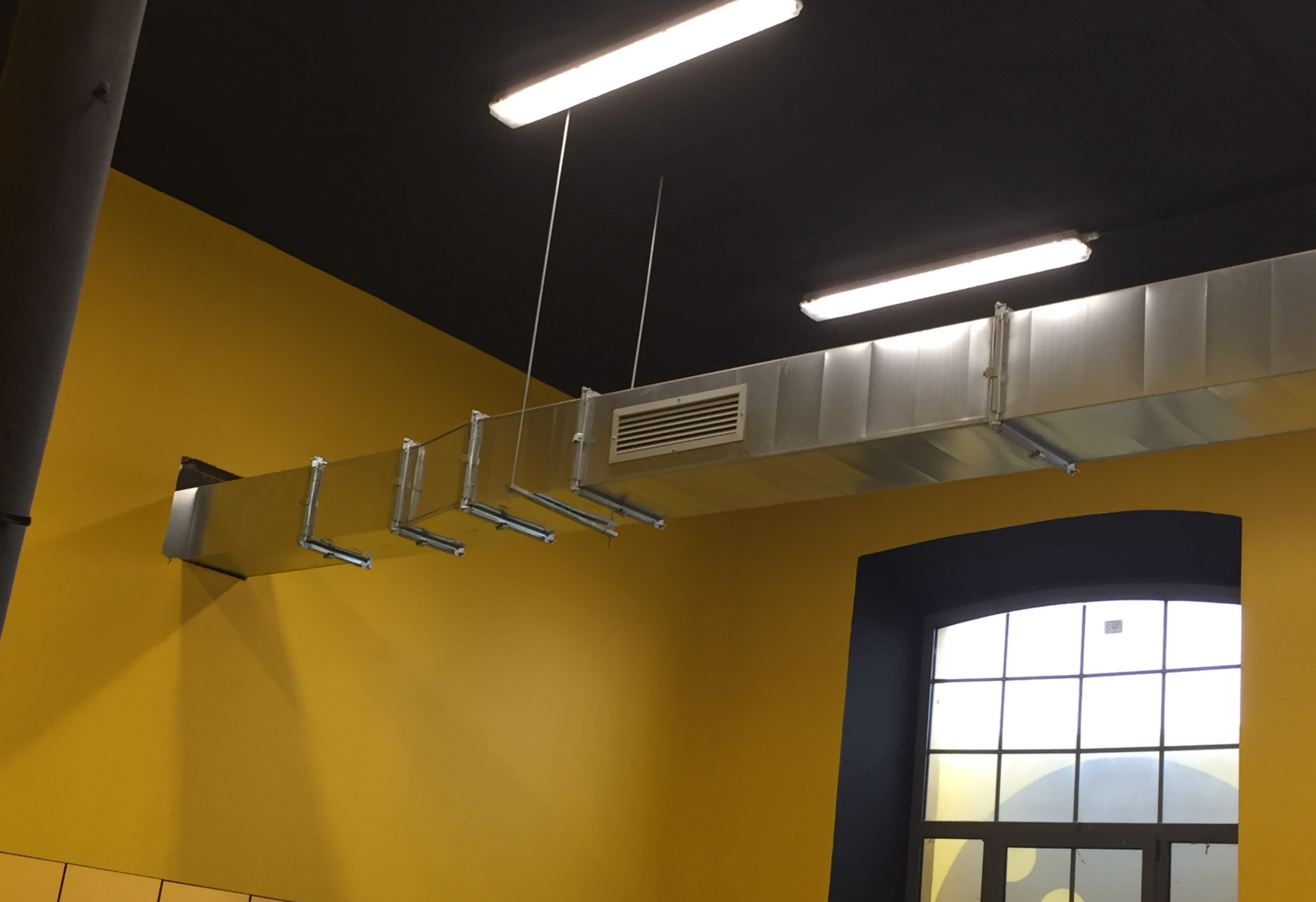
Vista del locale a lavorazioni ultimate. Canalizzazioni
