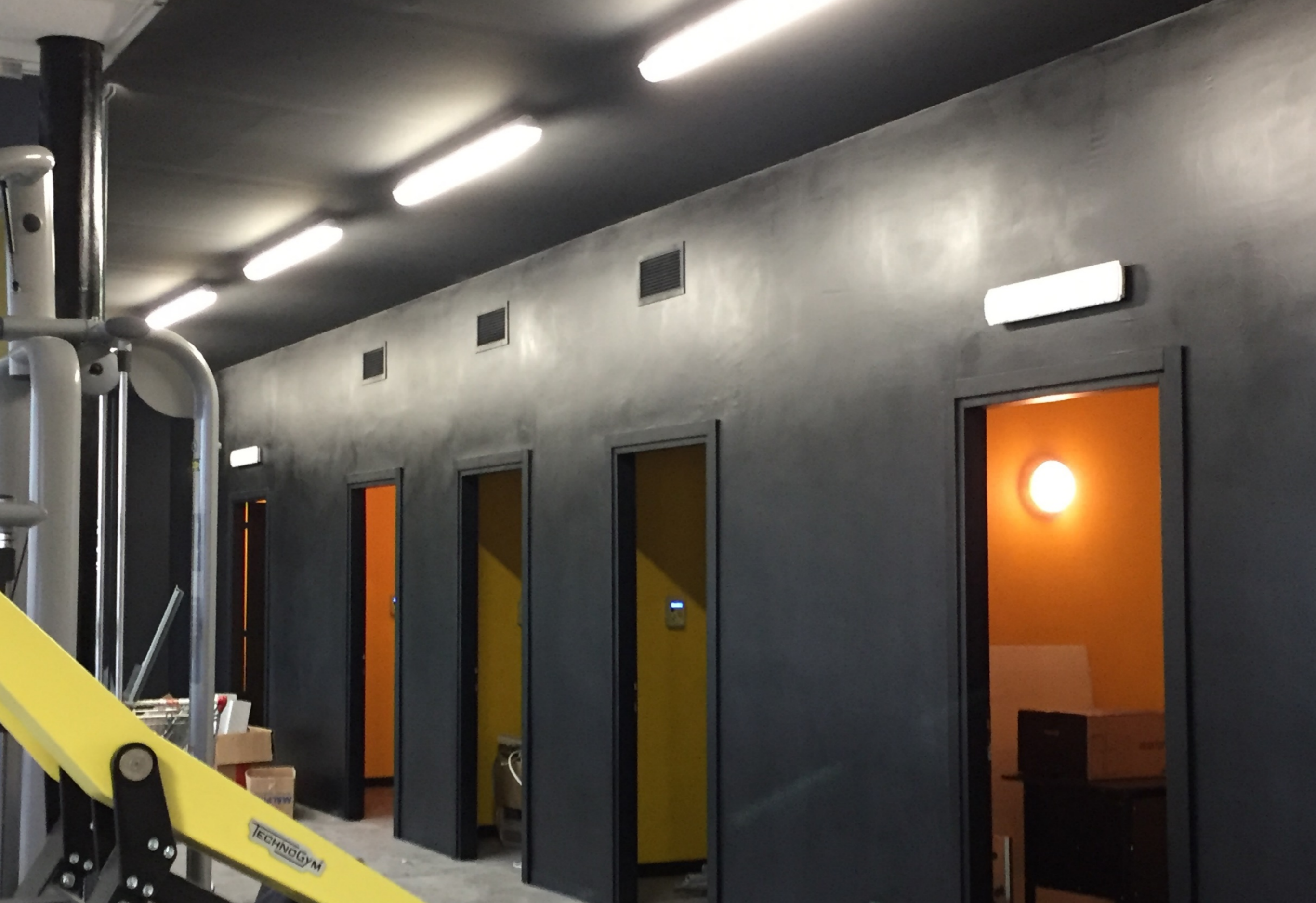
Vista del locale durante le lavorazioni. Finiture
