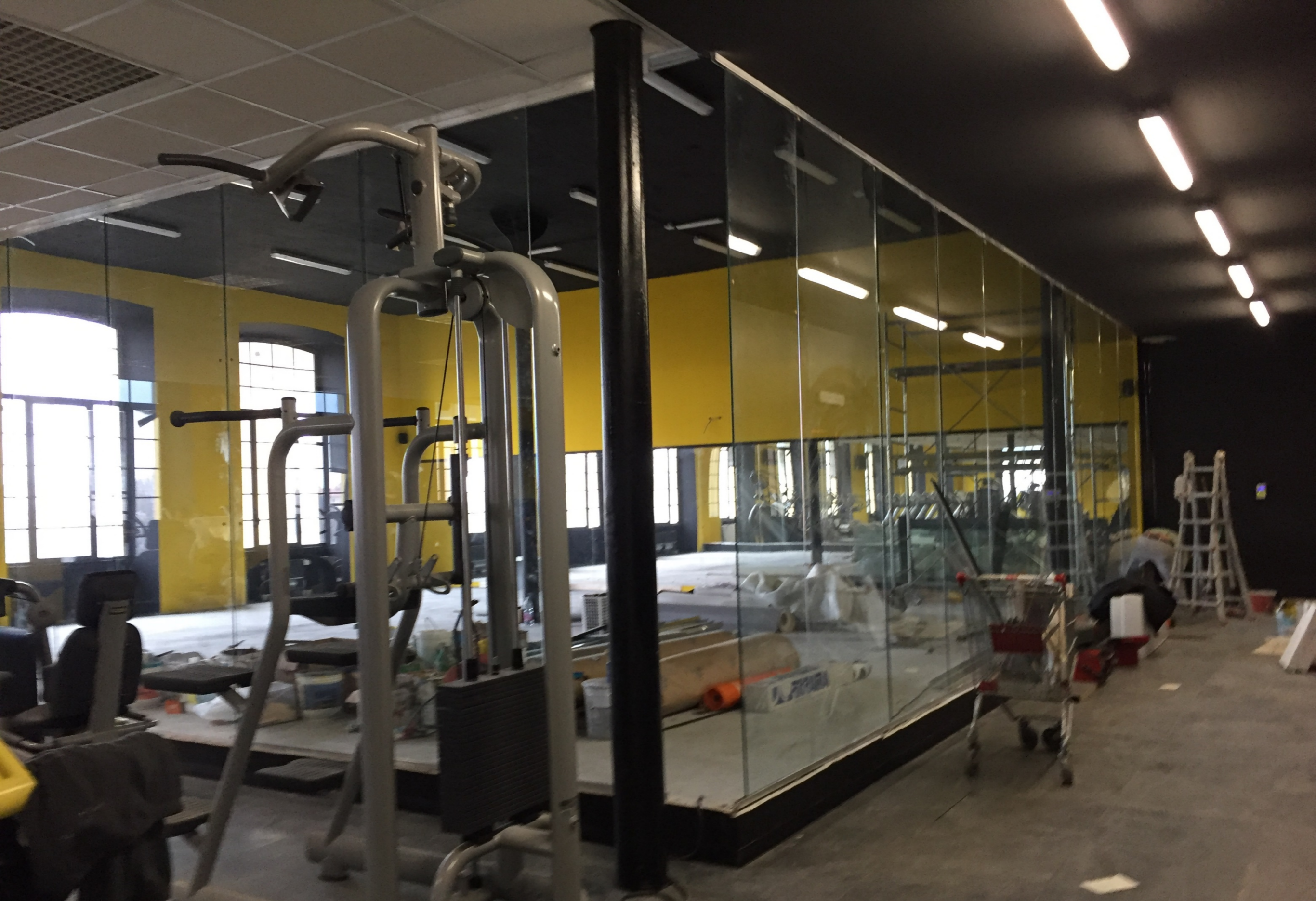
Vista del locale durante le lavorazioni
