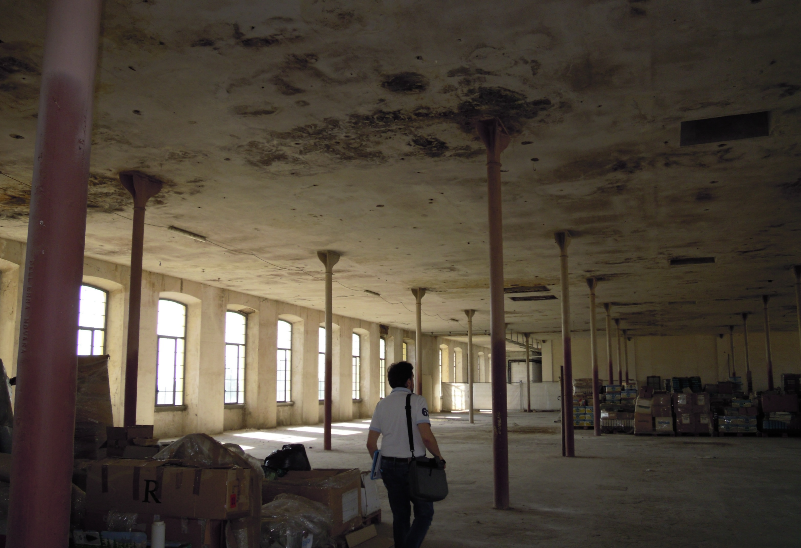
Vista del locale antecedente i lavori
