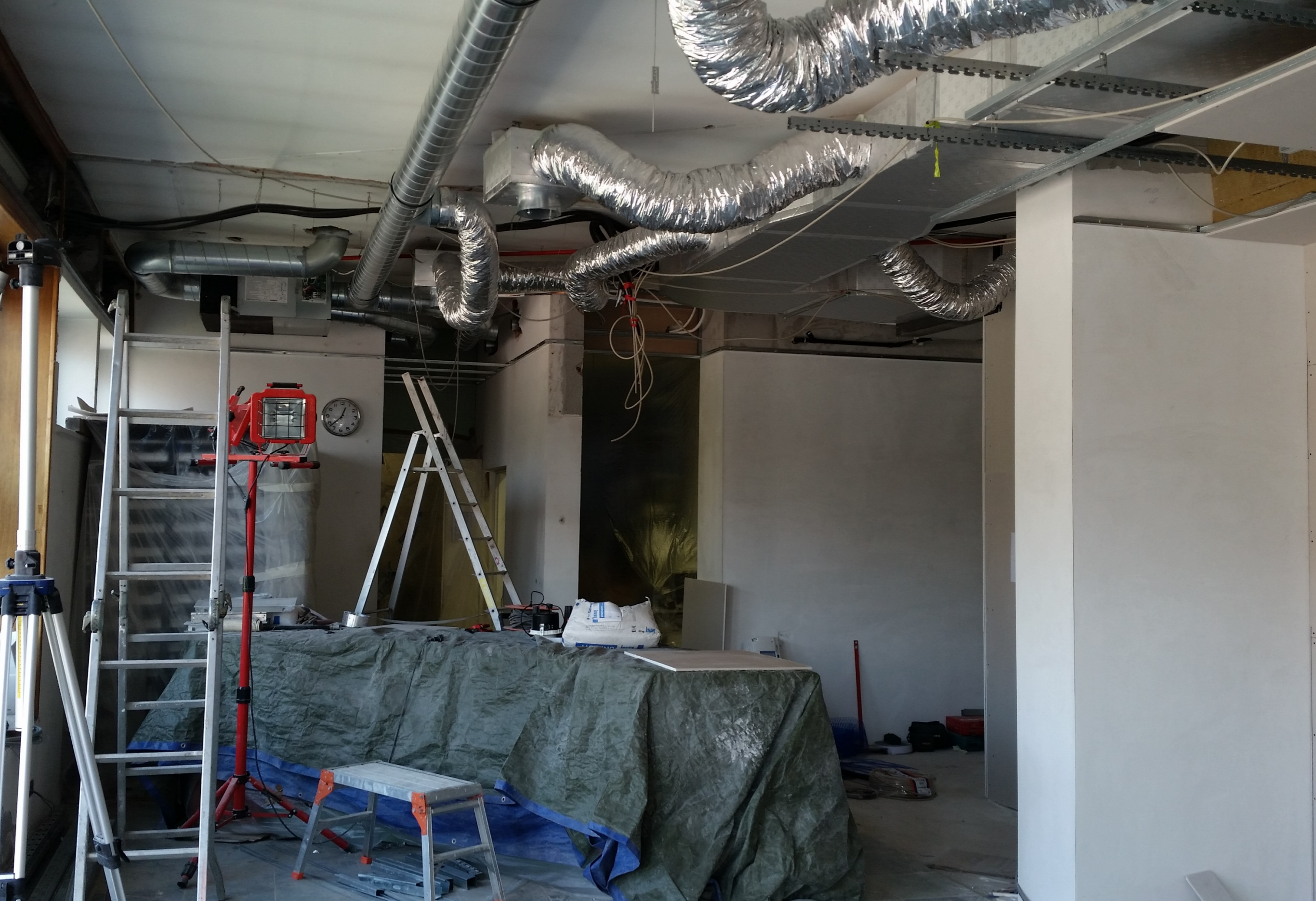
Esecuzione impianti: canalizzazione impianto di trattamento aria e condizionamento
