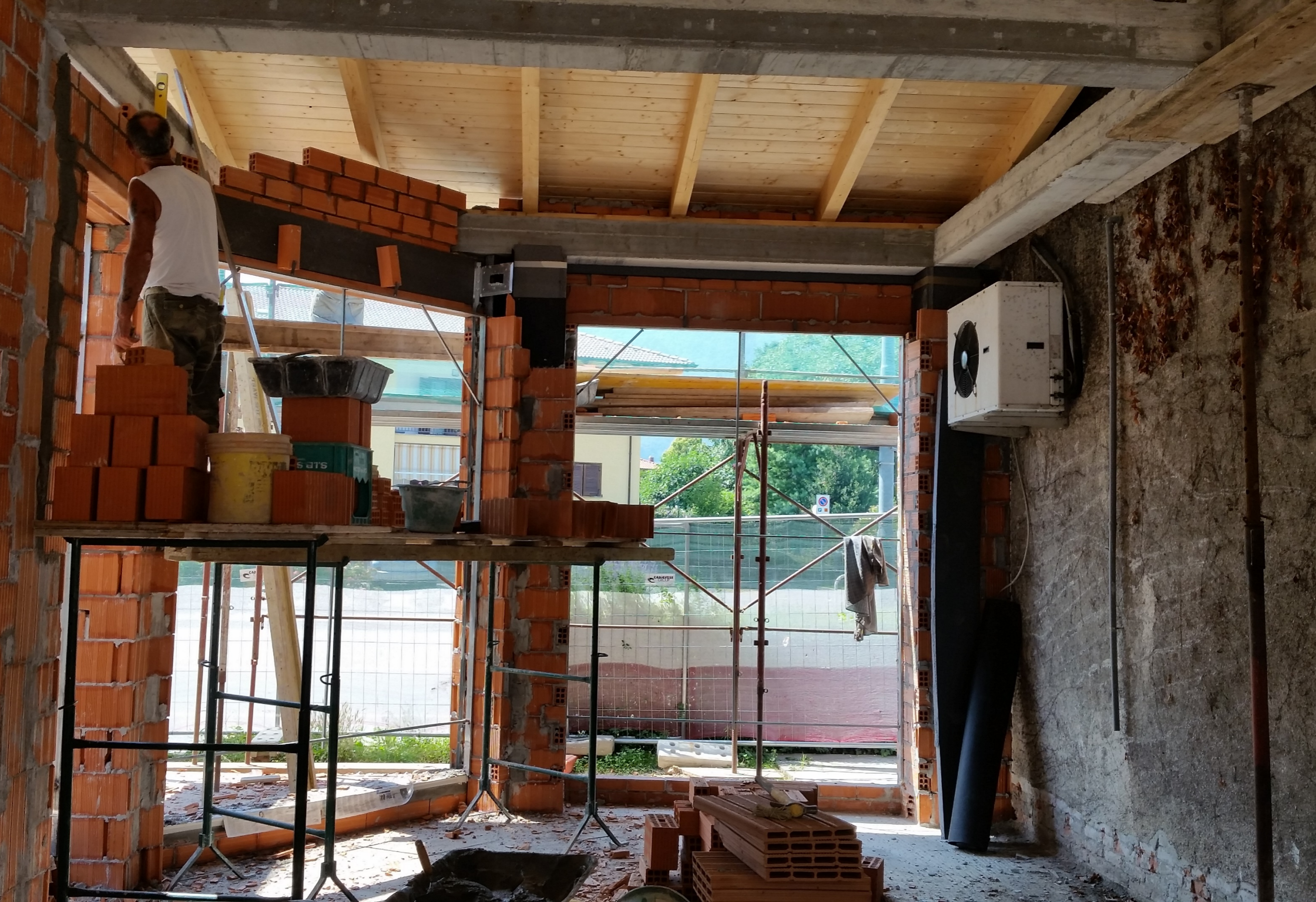
Vista interna dell'ampliamento durante i lavori
