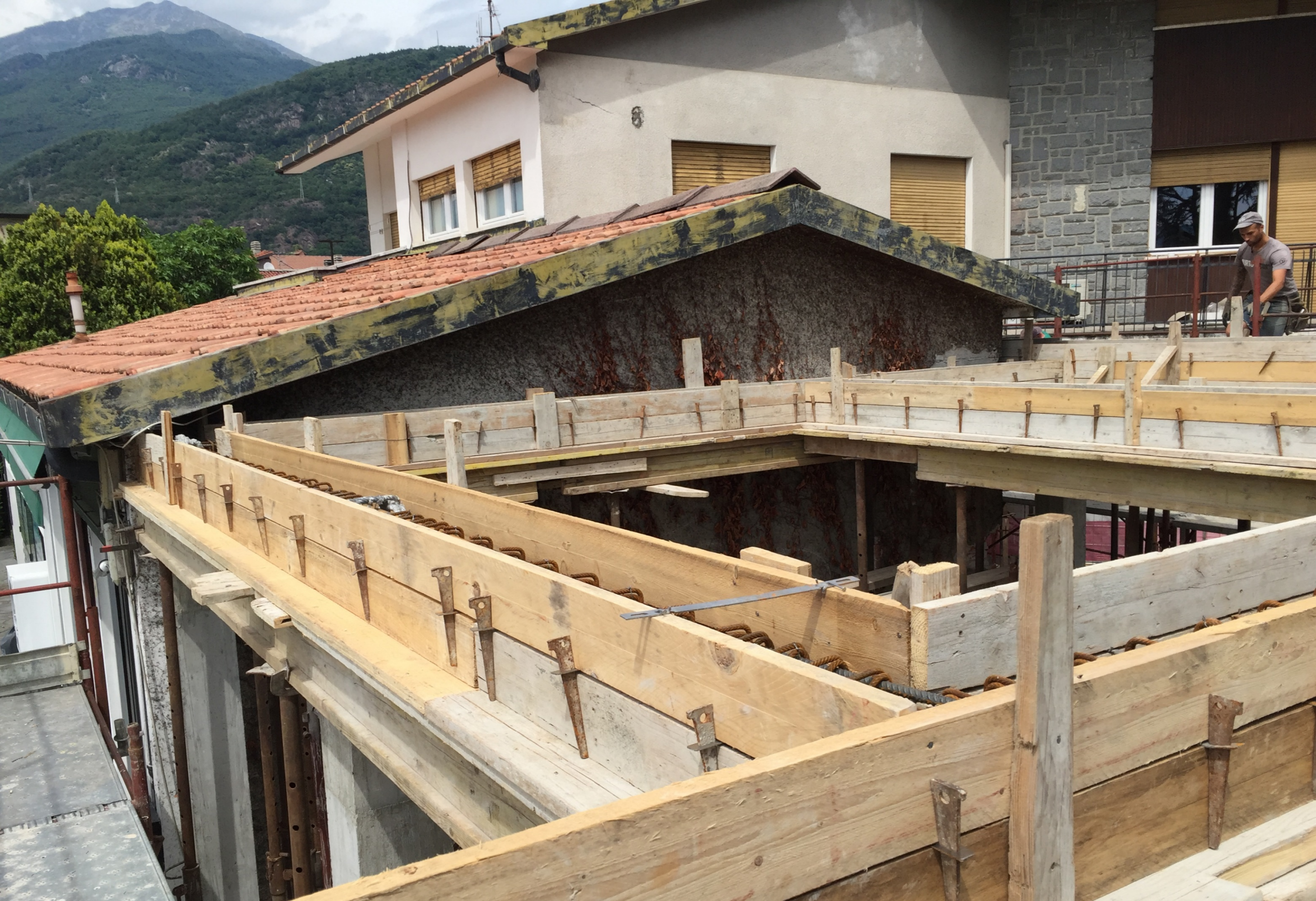
Particolare delle nuove strutture durante i lavori
