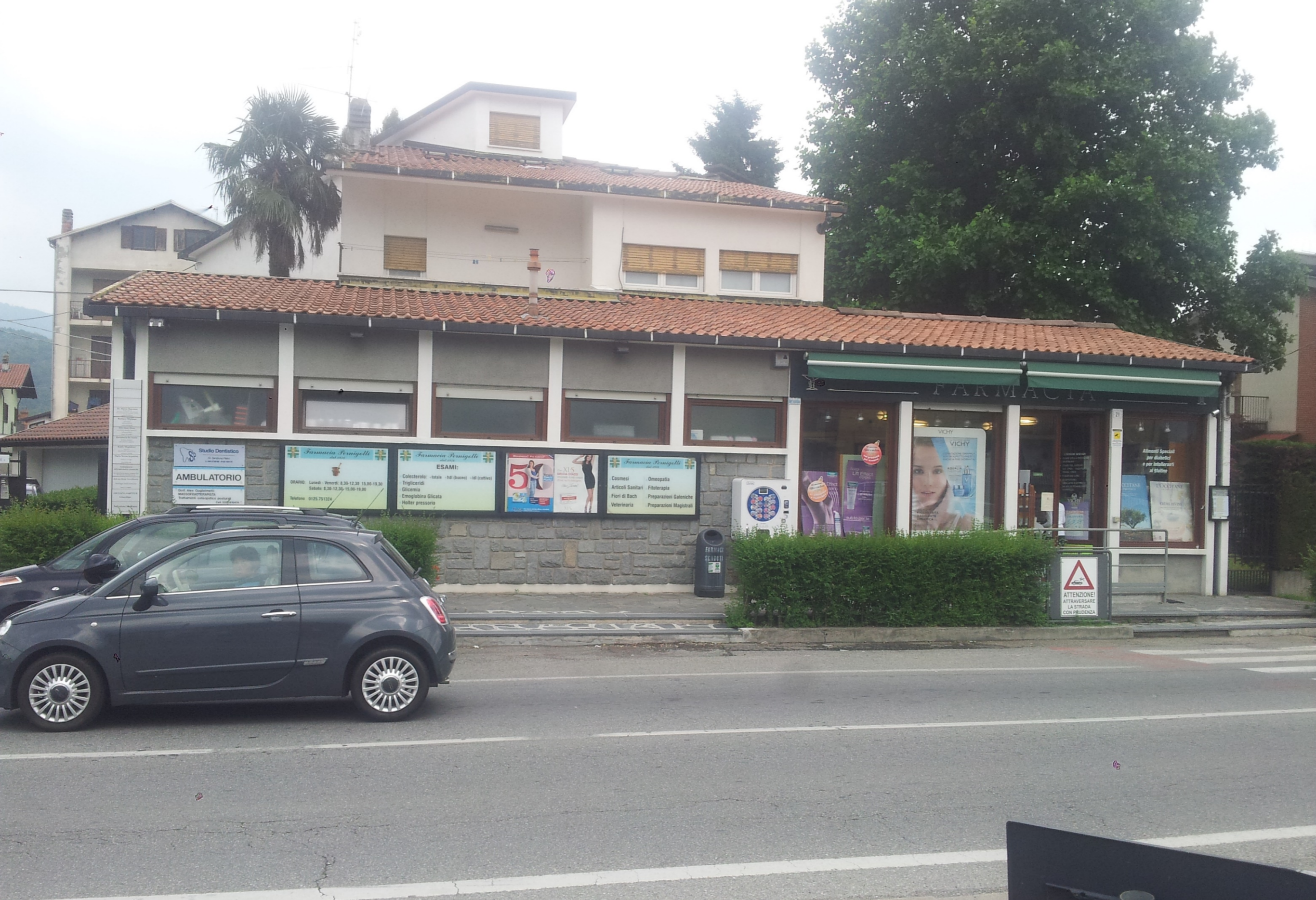
Vista dell' edificio antecedente l'intervento
