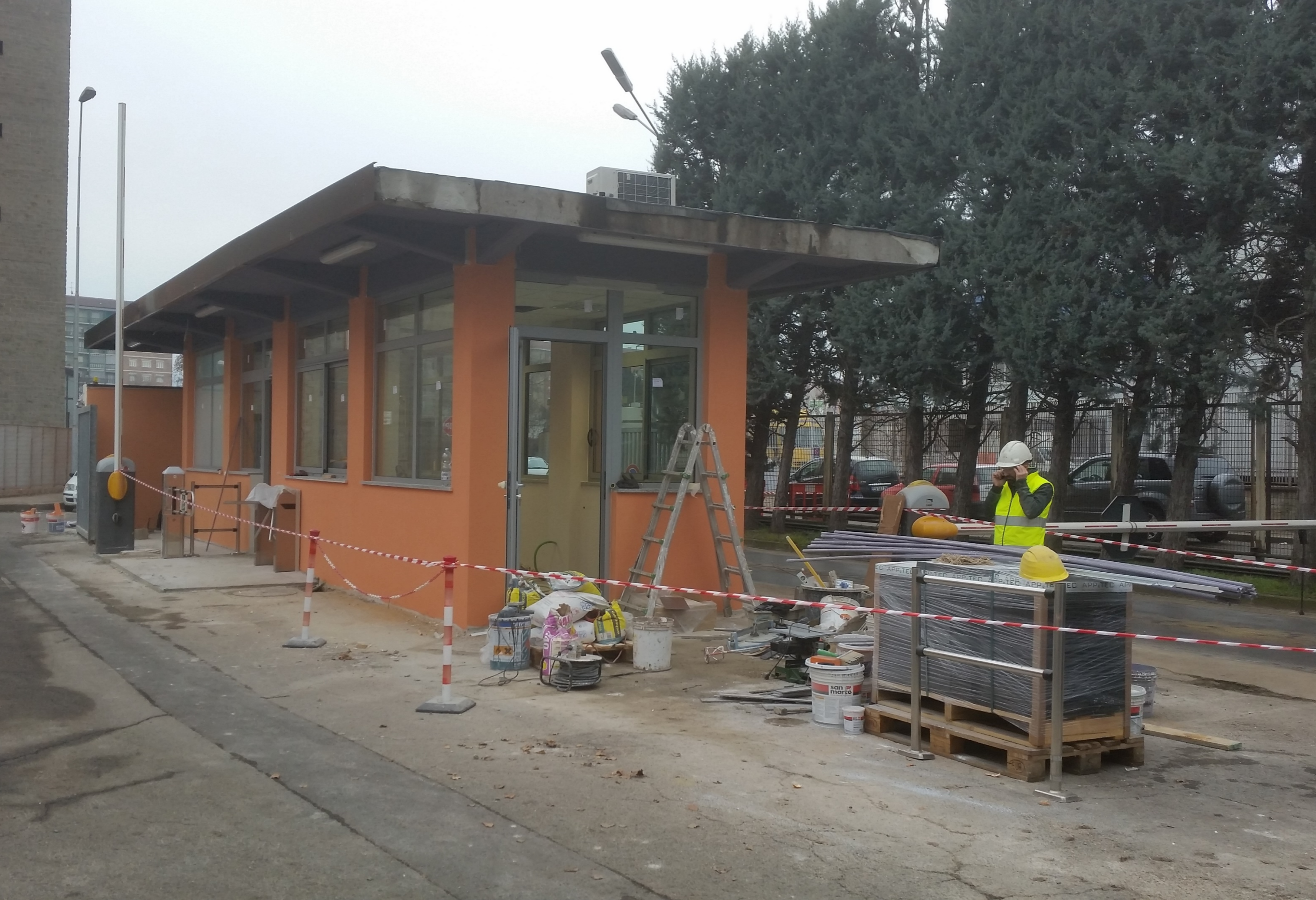
Fasi finali del cantiere
