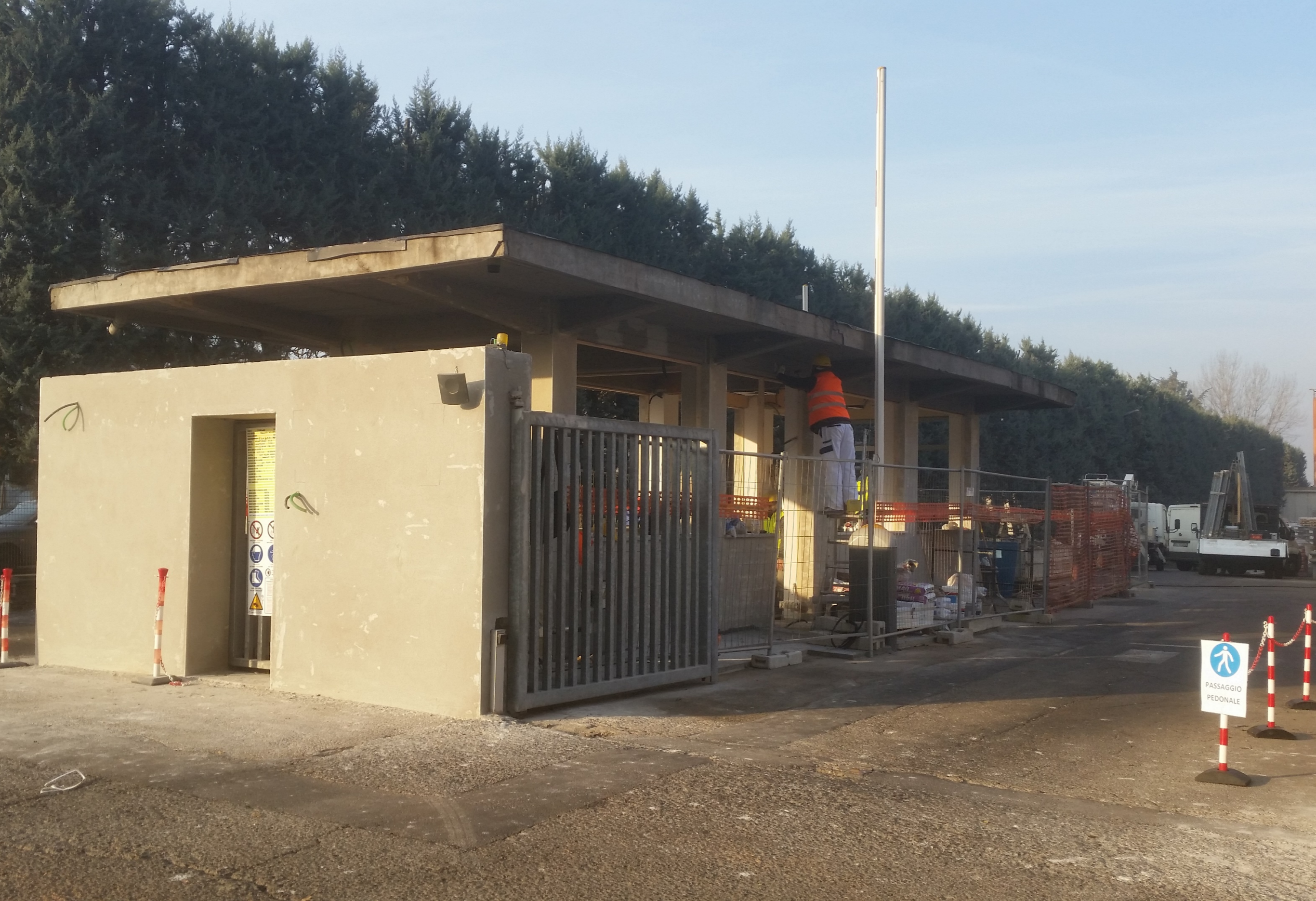
Cantiere durante i lavori di ristrutturazione
