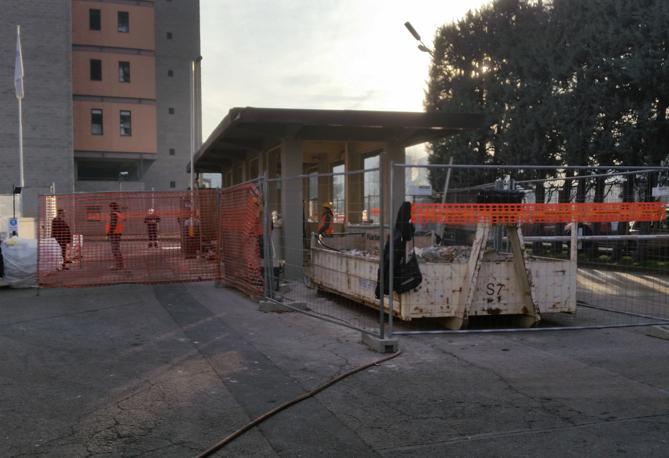
Cantiere durante i lavori di ristrutturazione
