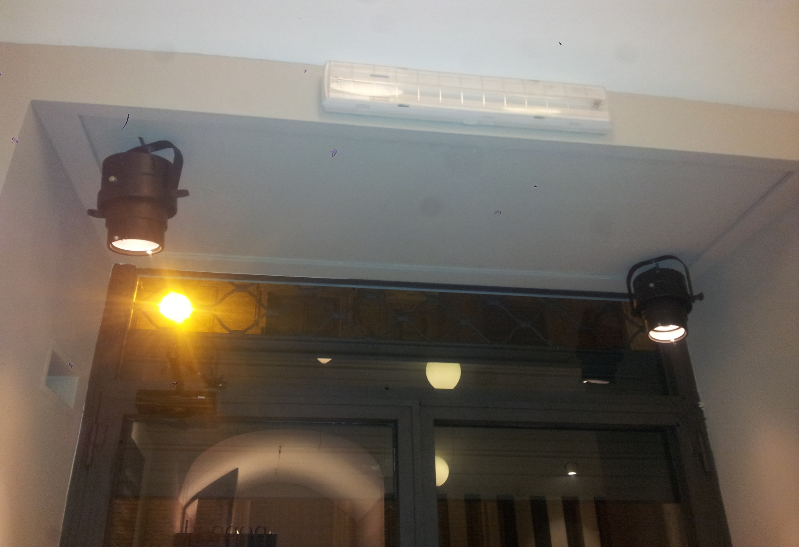
Vista interna a completamento dei lavori
