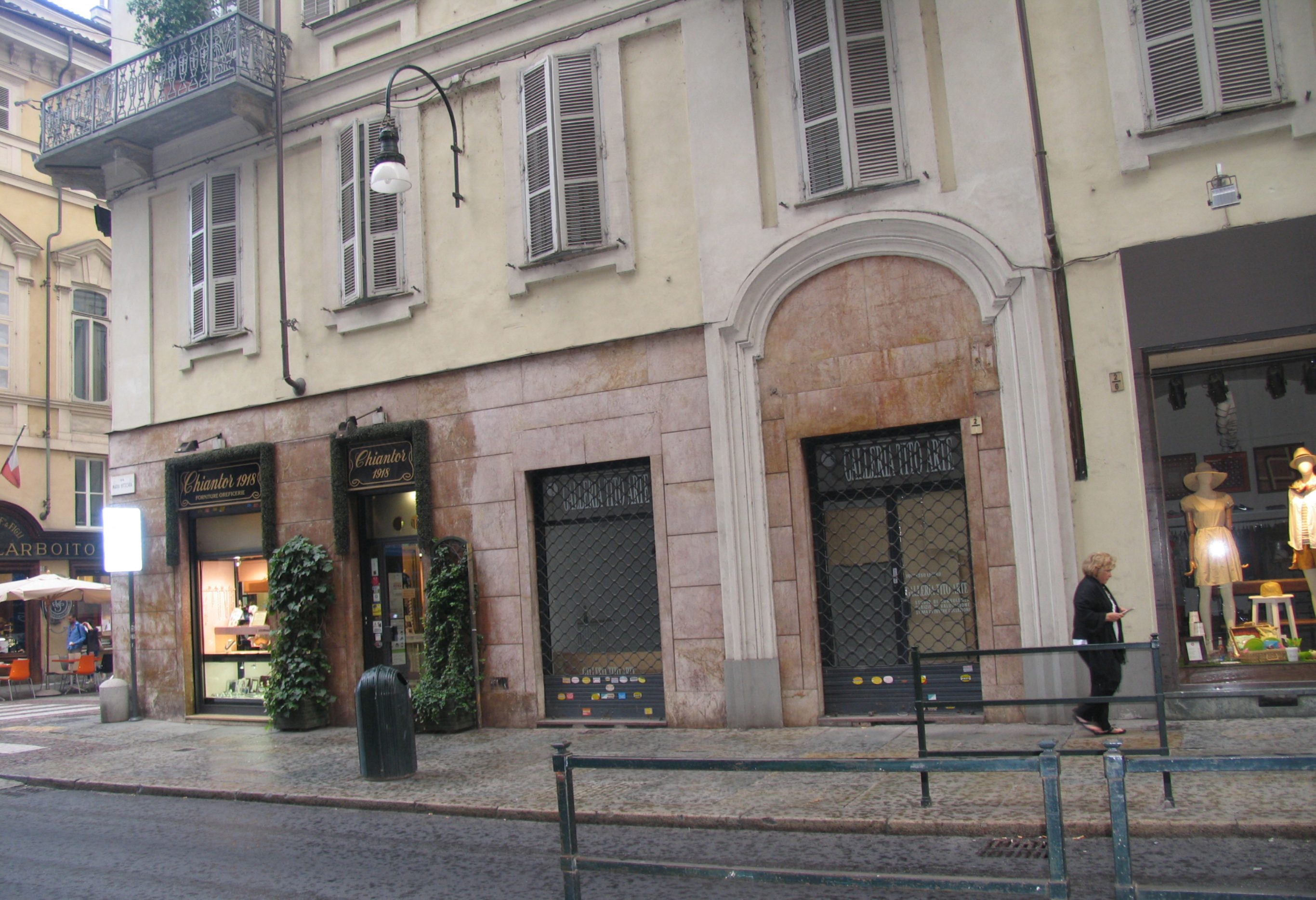
Vista esterna antecedente l'intervento
