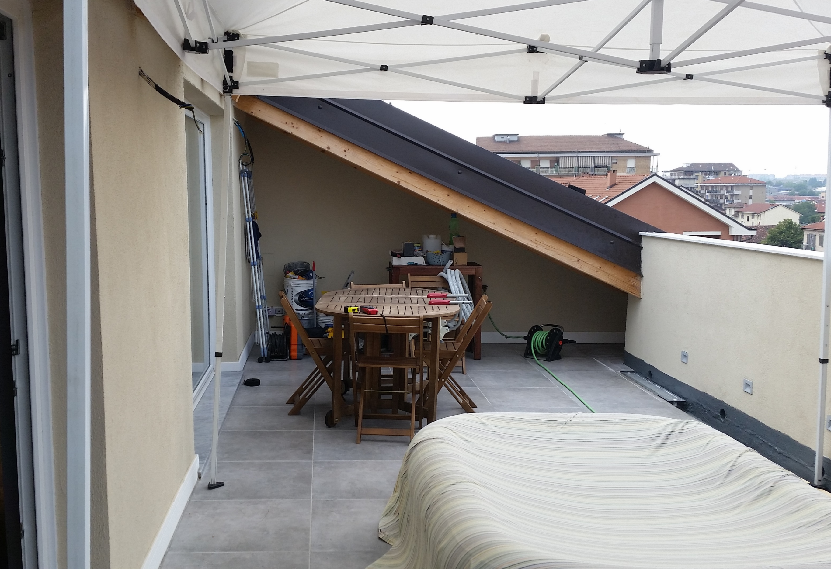
Vista terrazzo a completamento dei lavori
