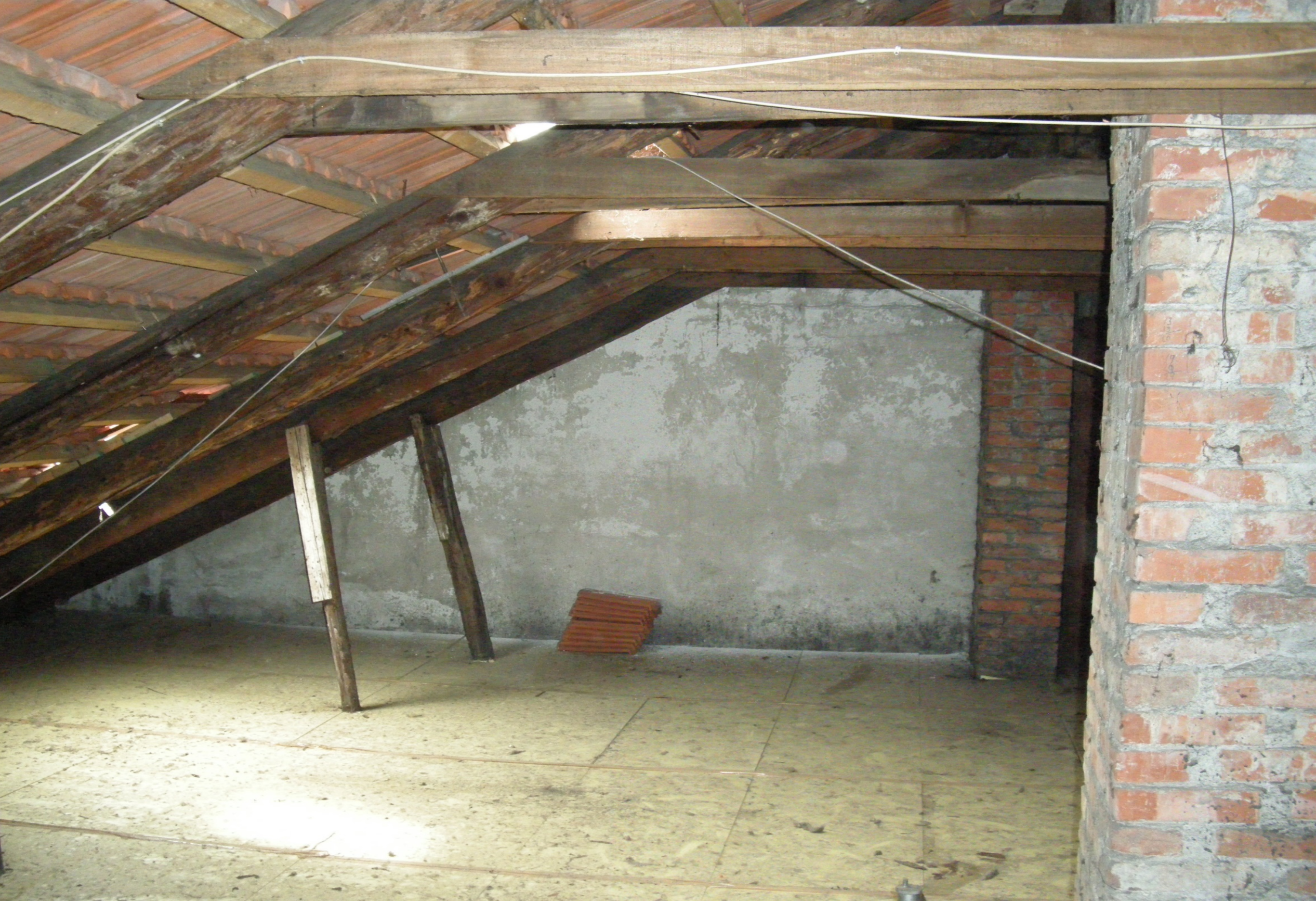
Vista interna del sottotetto antecedente i lavori
