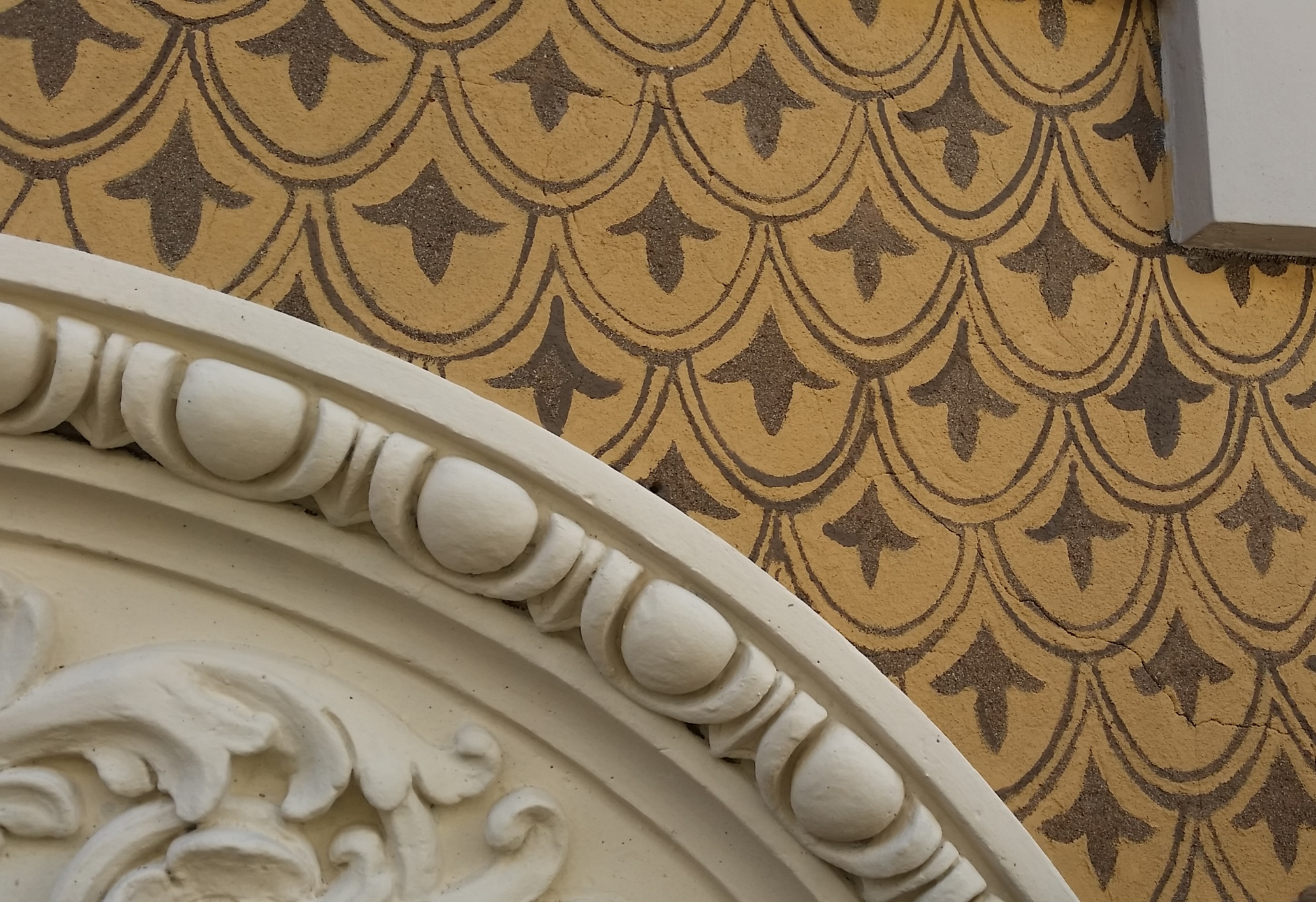
Vista di un elemento decorativo di facciata a restauro ultimato
