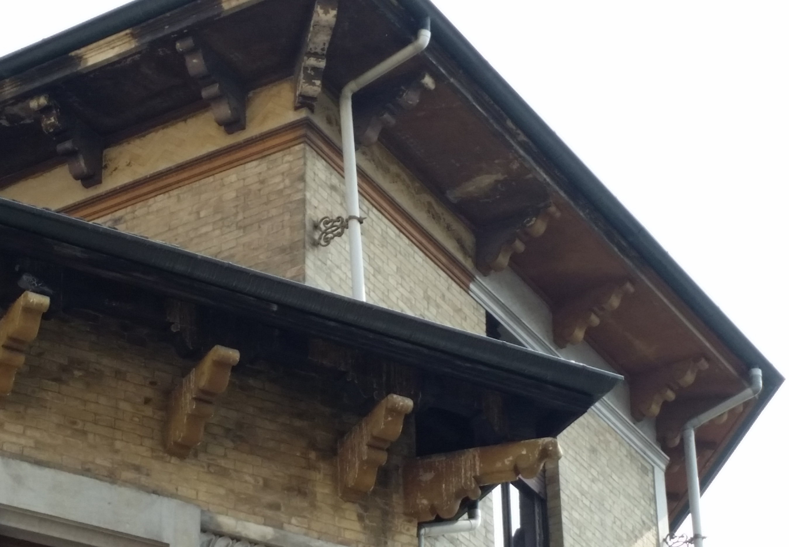
Vista degli elementi decorativi della facciata e della copertura antecedente l'intervento
