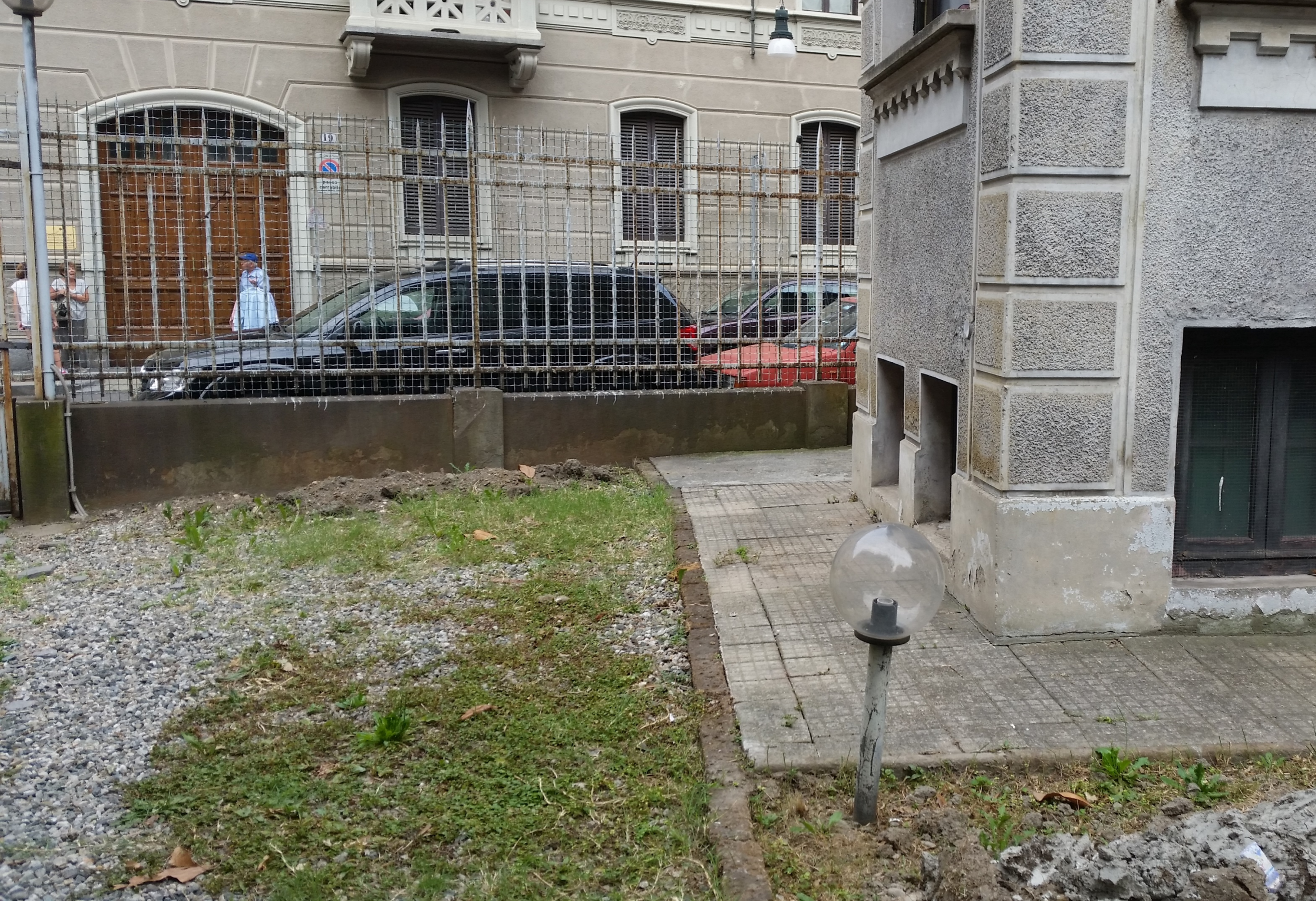
Vista del cortile interno antecedente i lavori
