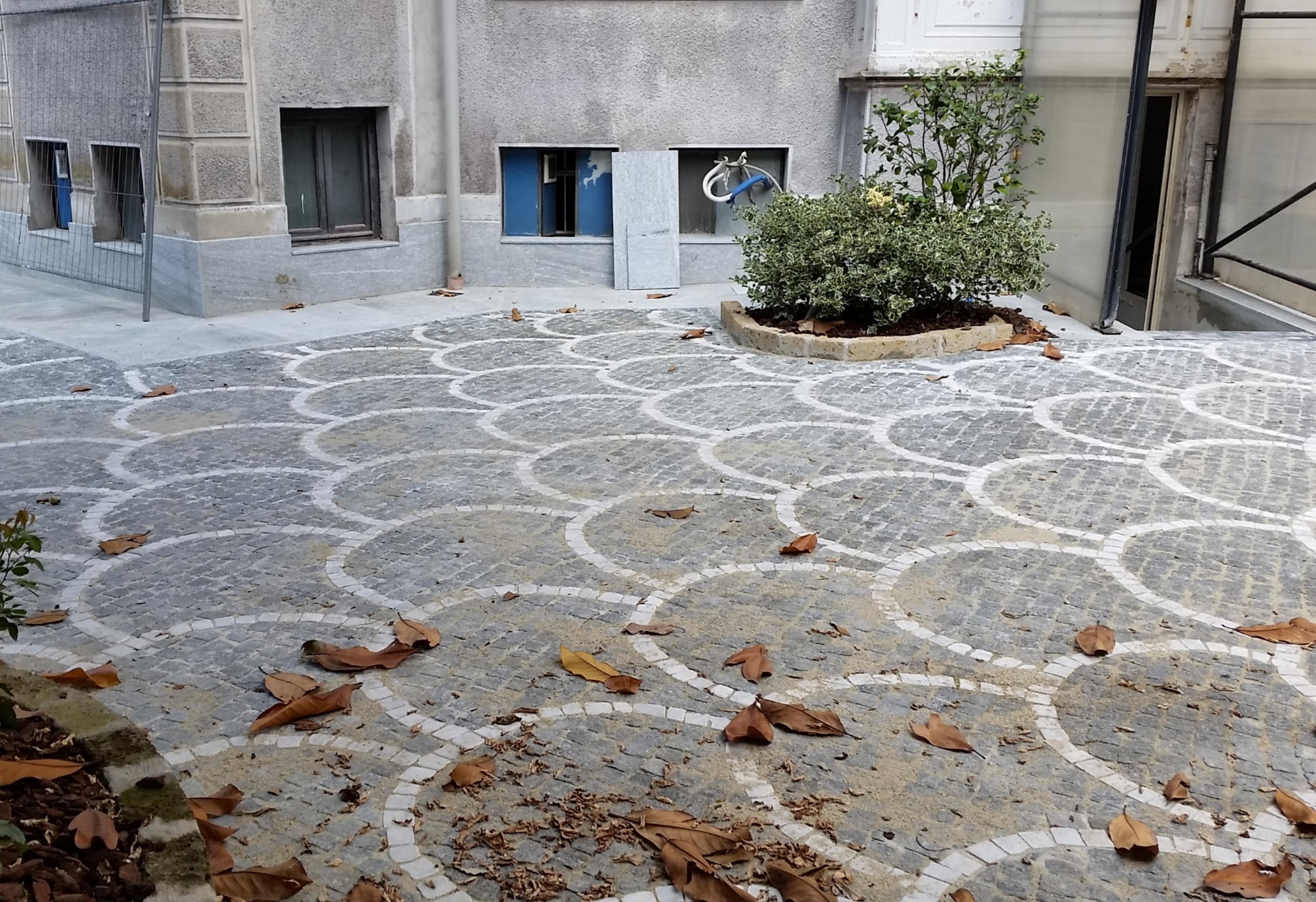
Vista del cortile interno a completamento dei lavori
