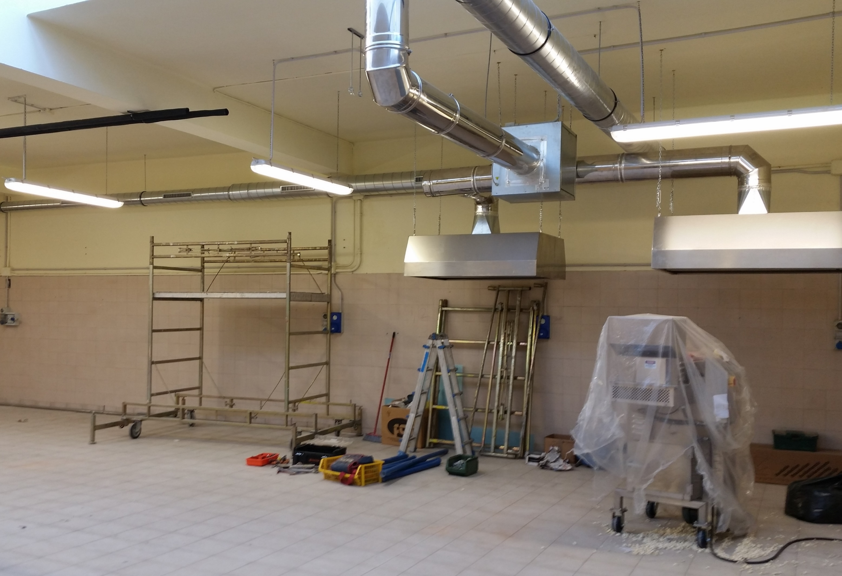
Posa impianto evacuazione fumi di cottura.
