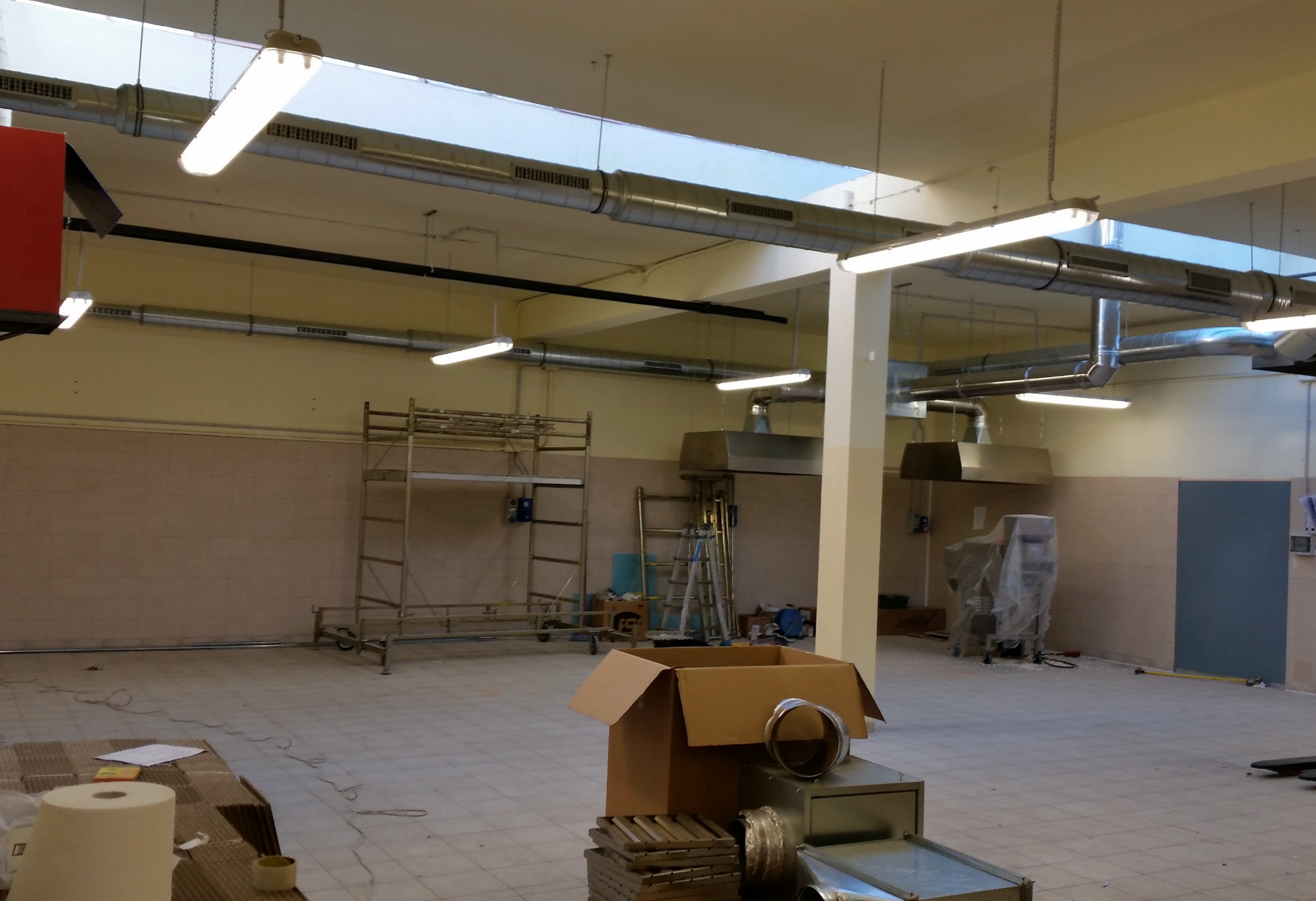
Posa impianto trattamento aria primaria
